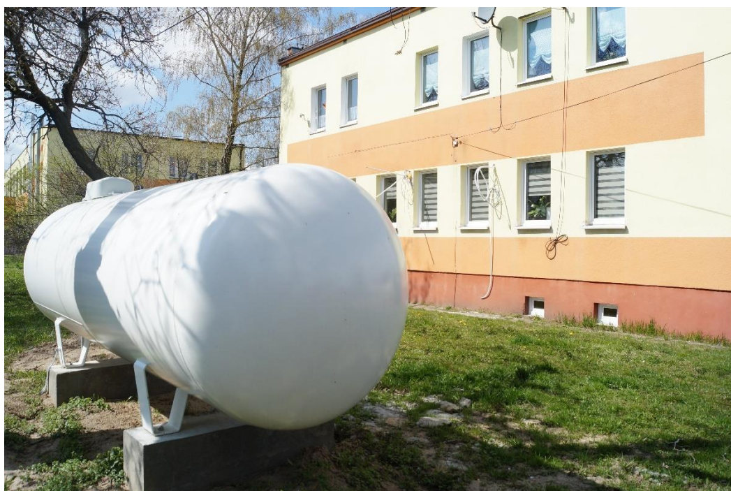
Modernizacja ogrzewania w budynku GOPS w Dąbrowie
