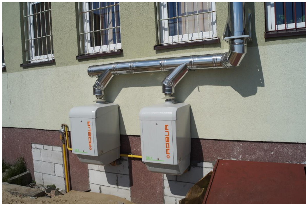
Wymiana źródła ciepła Urząd Gminy w Dąbrowie
