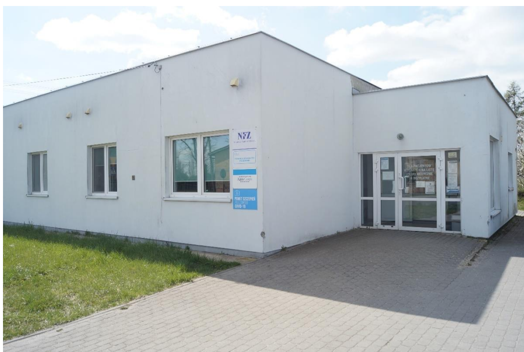
Zakup budynku Ośrodka Zdrowia w Dąbrowie
