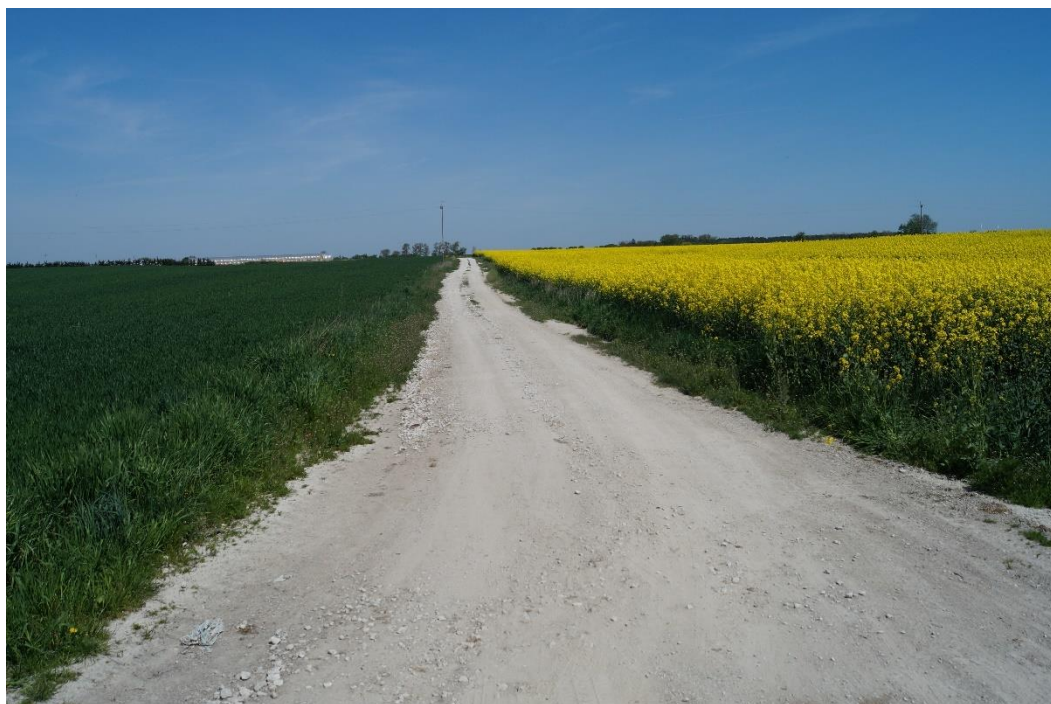
Droga gruntowa Szubinek – Sędowo
