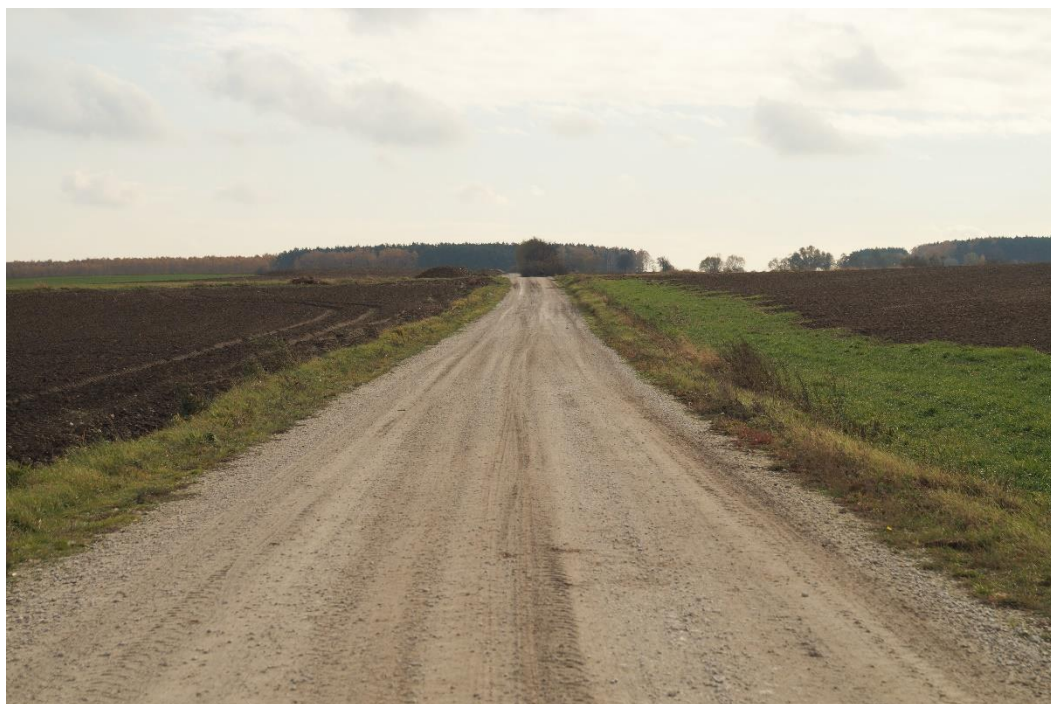
Droga gruntowa Parlinek – Chwałowo
