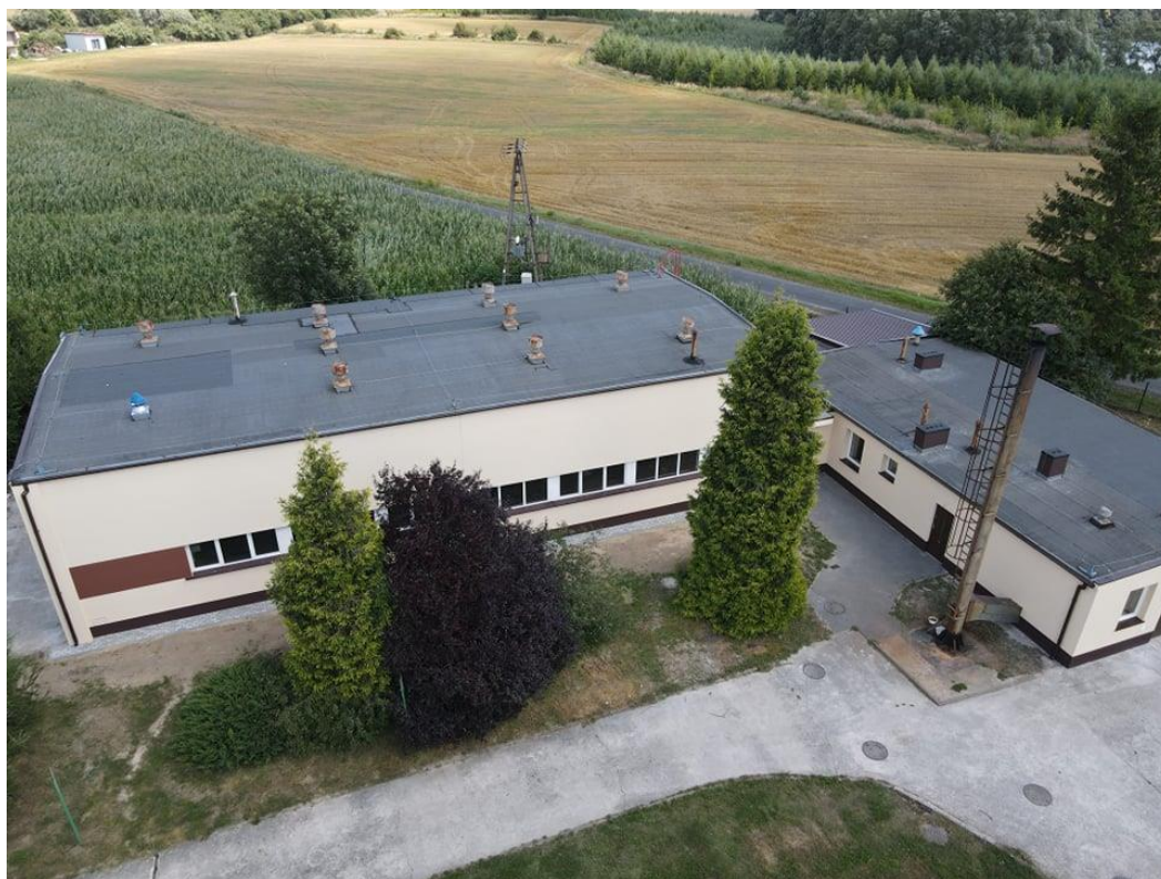
Termomodernizacja Stacji Uzdatniania Wody Krzekotowo
