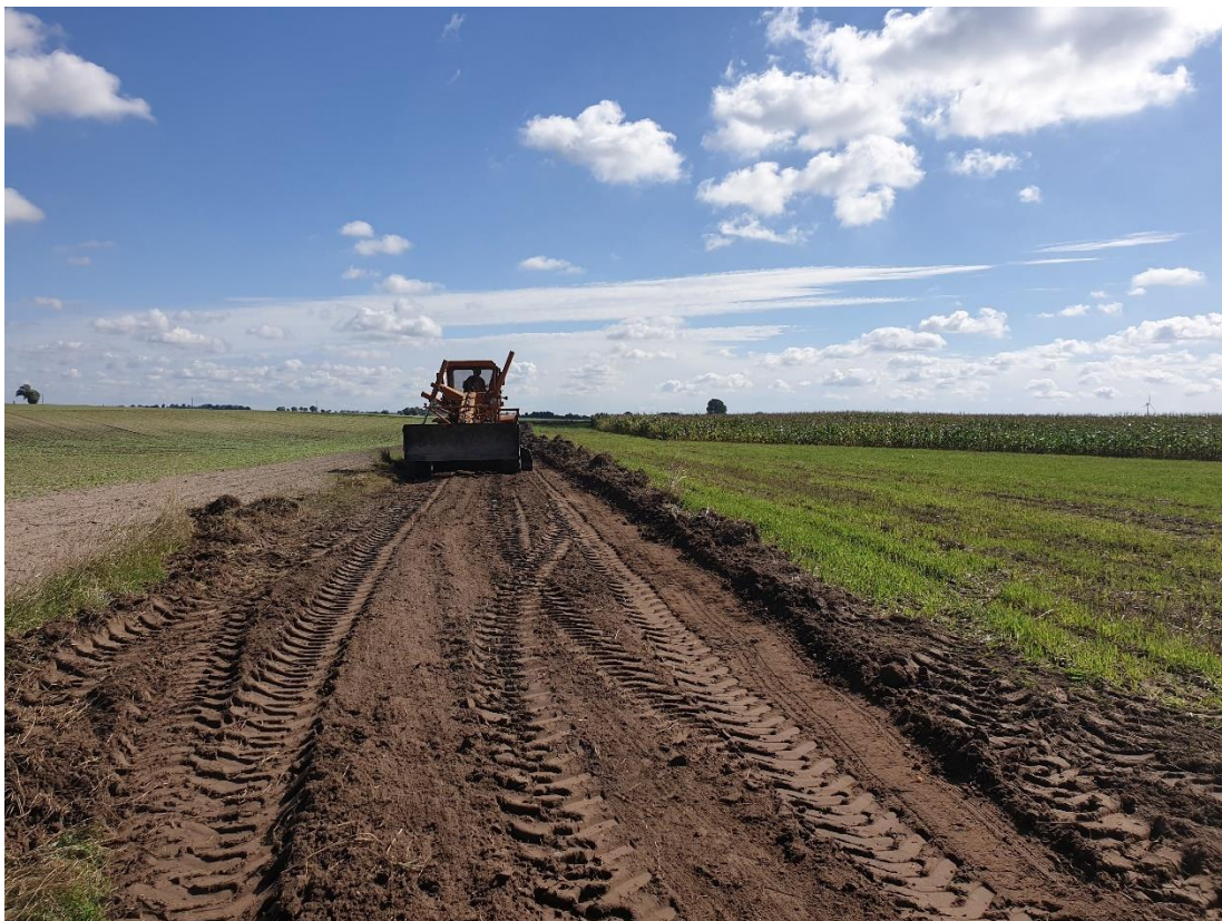
Droga gruntowa Krzekotowo
