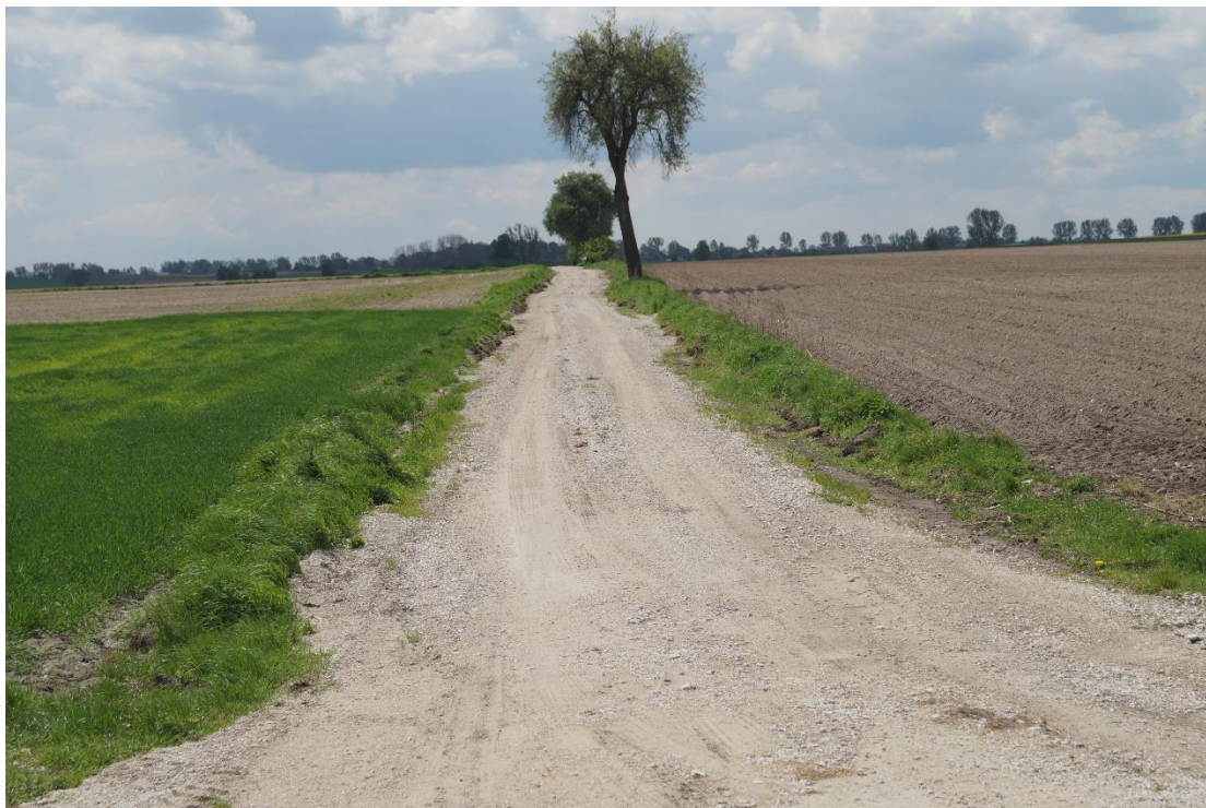
Droga gruntowa Szczepankowo - Mokre
