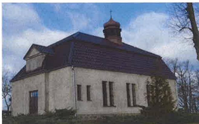
Fot. 9. Dawny kościół ewangelicki, obecnie kaplica
