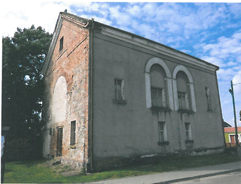
Fot. 4. Poewangelicki kościół w Dąbrowie – elewacja północno-wschodnia Źródło: fotografia własna
