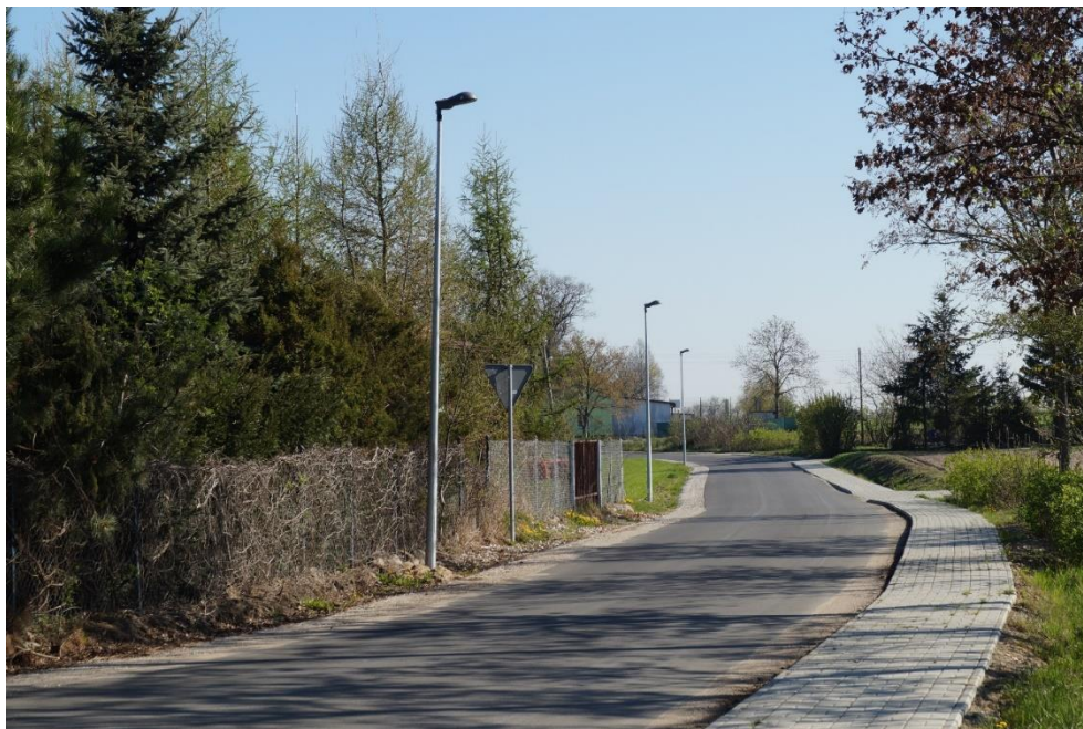
Modernizacja oświetlenia w ciągu drogi gminnej w miejscowości Sucharzewo- wartość inwestycji - 20.619,90 zł
