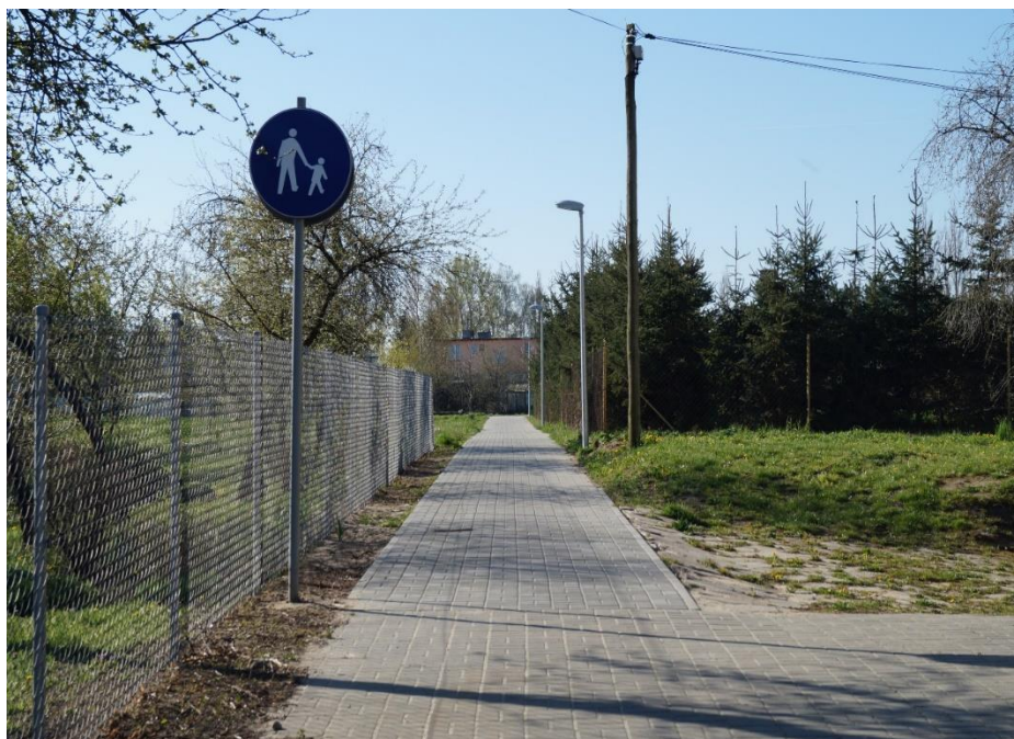
Modernizacja ścieżki pieszo-rowerowej pomiędzy ul. Szkolną i ul. Sportową w Dąbrowie z budową 2 lamp – 374m 2 – wartość inwestycji 50 711,12 zł
