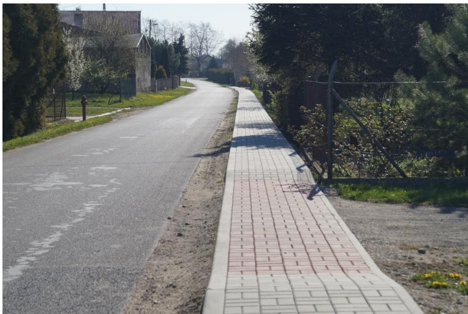
Modernizacja chodnika w miejscowości Sędowo 181 m 2 – wartość inwestycji 30 034,72 zł
