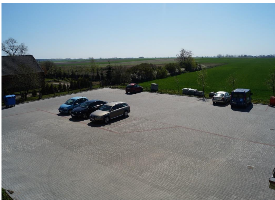
Budowa parkingu przy Urzędzie Gminy w Dąbrowie – łączna powierzchnia – 1007 m 2 Wartość inwestycji – 119.555,53 zł
