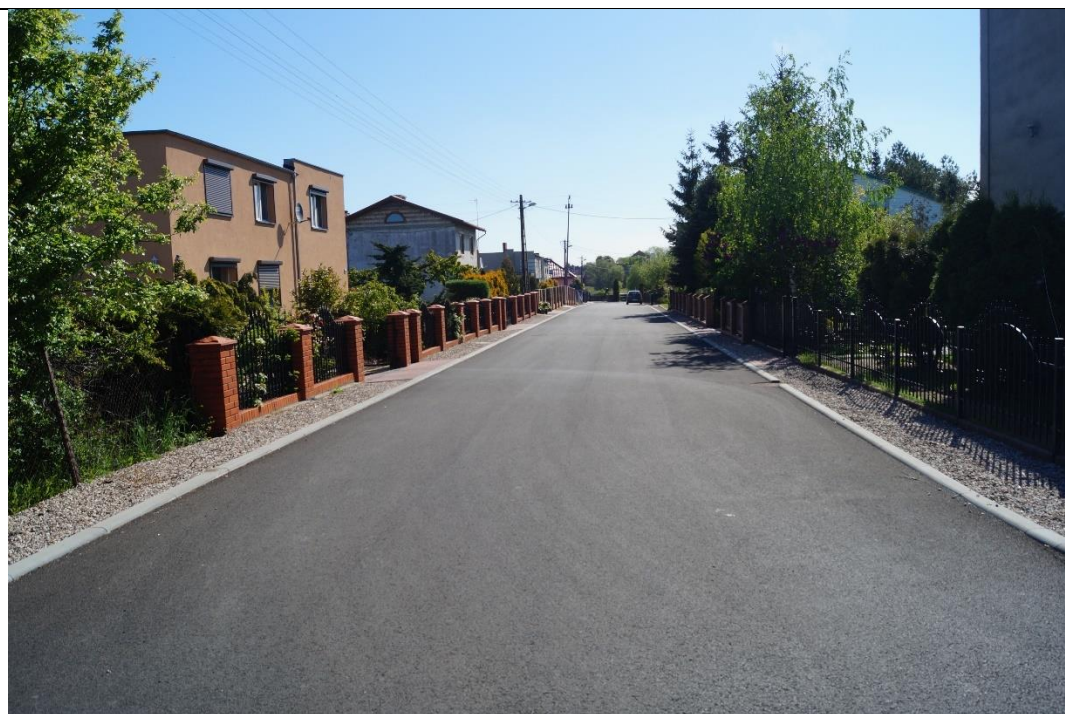
Modernizacja ulicy Słonecznej w Dąbrowie wartości inwestycji 553 440,14 zł
