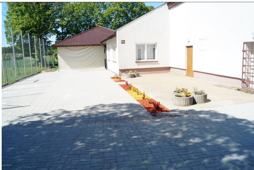
Parking przy świetlicy Białe Błota, wartość inwestycji 12 985,34 zł
