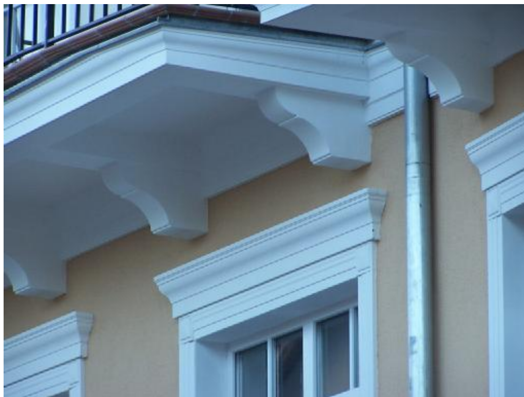
Zdjęcie nr 6 – Widok elewacji.
