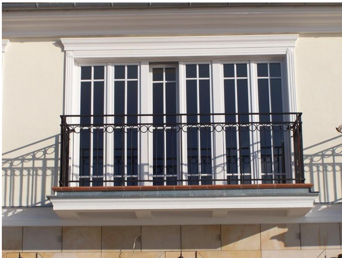
Zdjęcie nr 5 – Widok elewacji.
