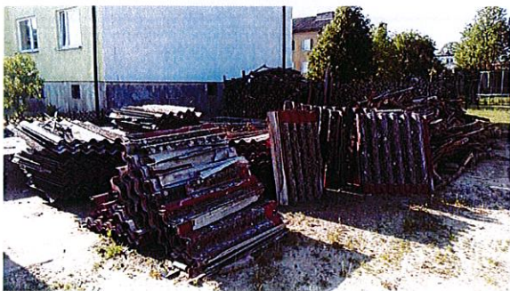
23. Budynek mieszkalny, Krępa 10/1, 76-020 Bobolice, Dz. nr 189/5 obr. Krępa – demontaż.
