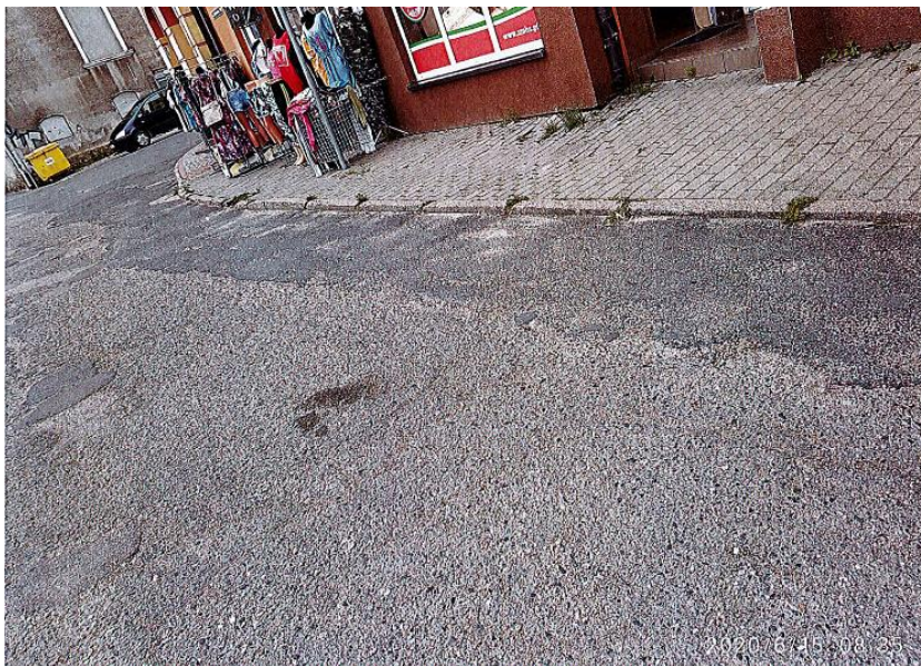
Rys. nr 4 Fragment drogi nr 147026Z.
