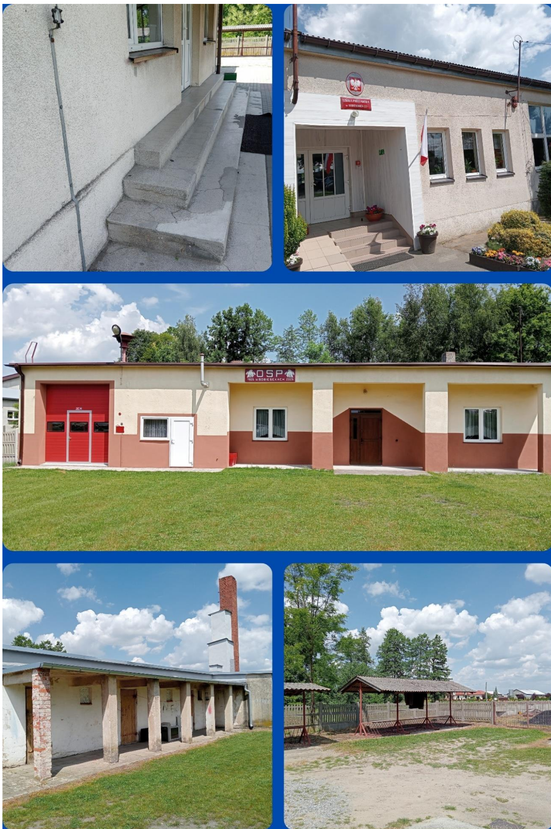
Rycina 10 Obiekty publiczne w złym stanie technicznym w Sobieszkach
