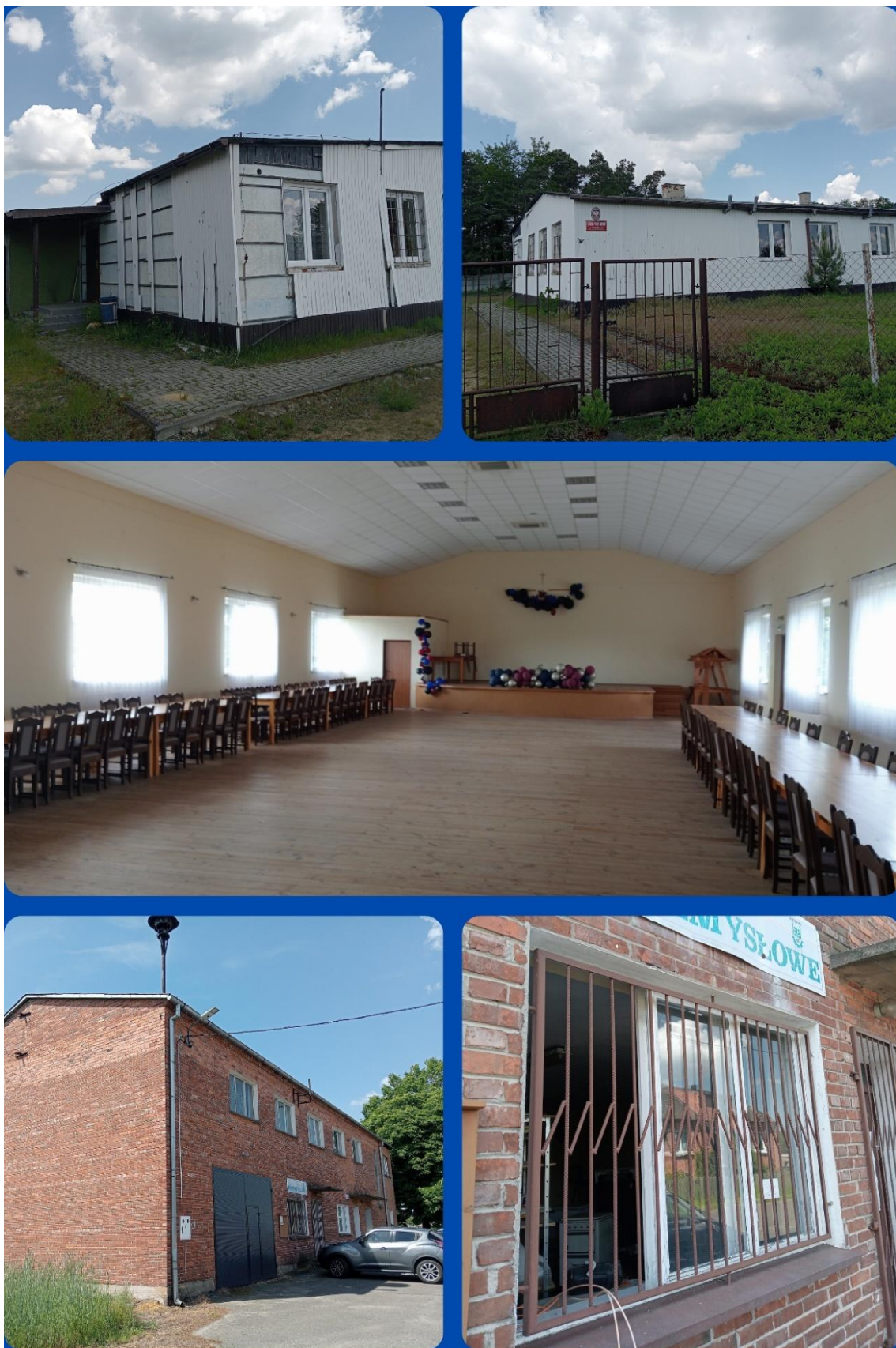
Rycina 11 Obiekty w złym stanie technicznym w miejscowościach: Dzieńcioły, Piegonisko-Wieś oraz Zagórna
