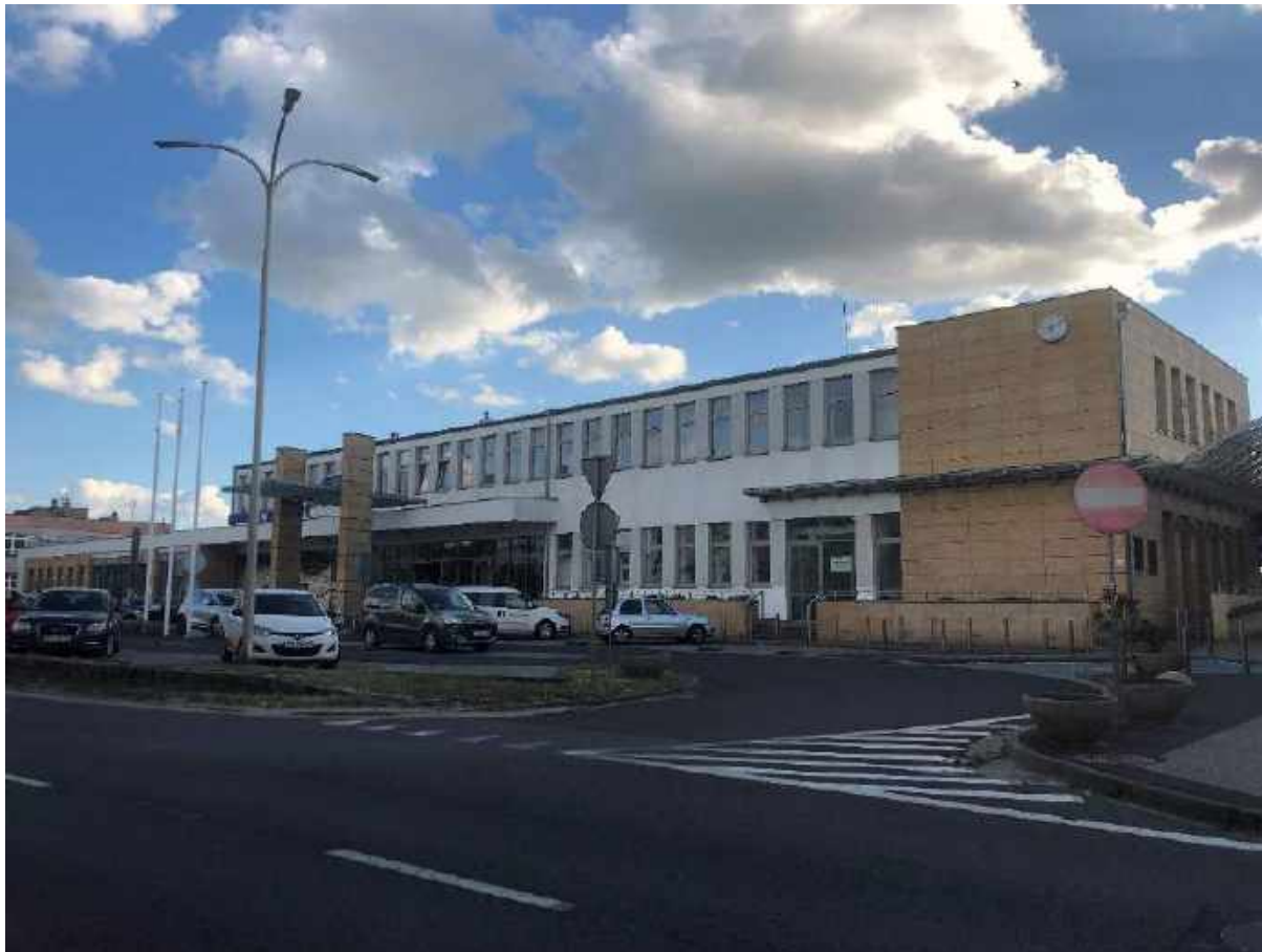
Zdjęcie 21. Dworzec kolejowy w Ostrowie Wielkopolskim.
