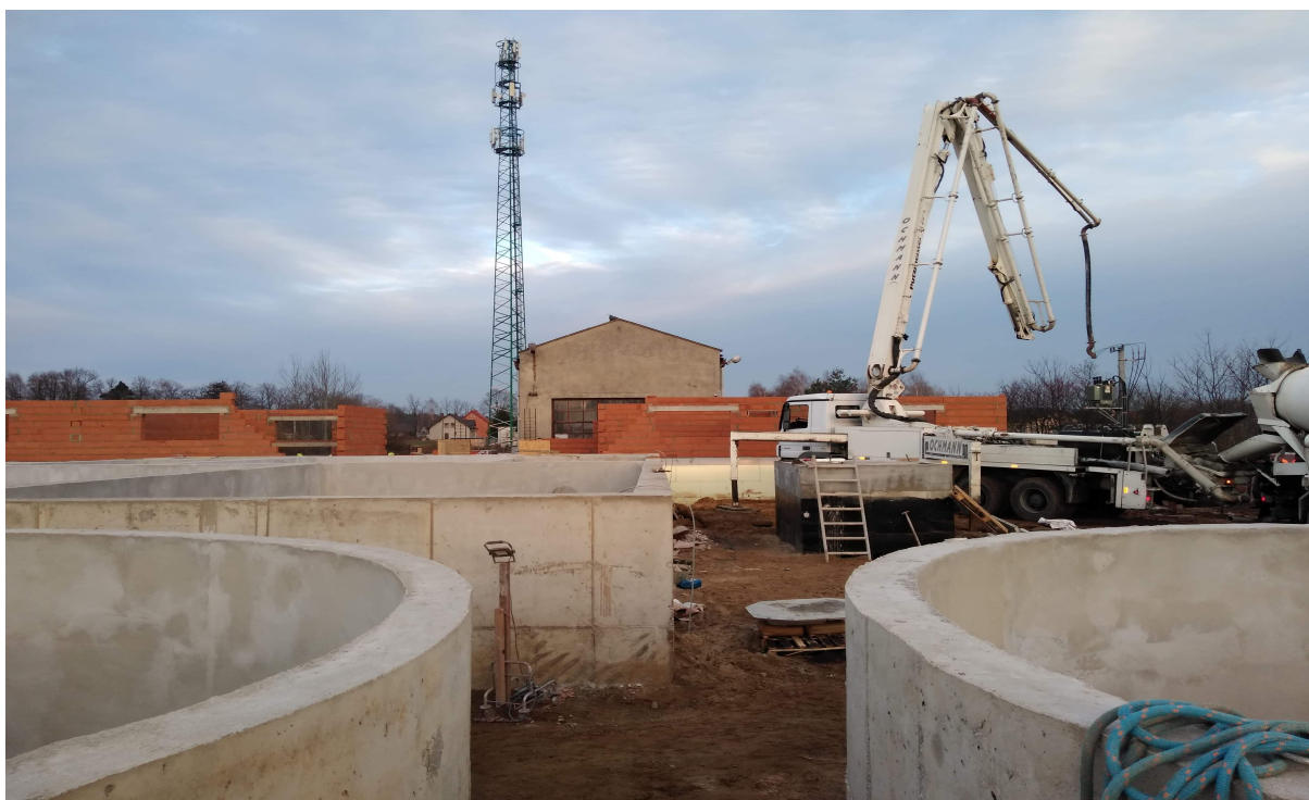
Fotografia nr 28 Rozbudowa i przebudowa oczyszczalni ścieków w miejscowości Brzeziny
