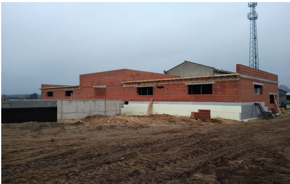
Fotografia nr 26 Rozbudowa i przebudowa oczyszczalni ścieków w miejscowości Brzeziny
