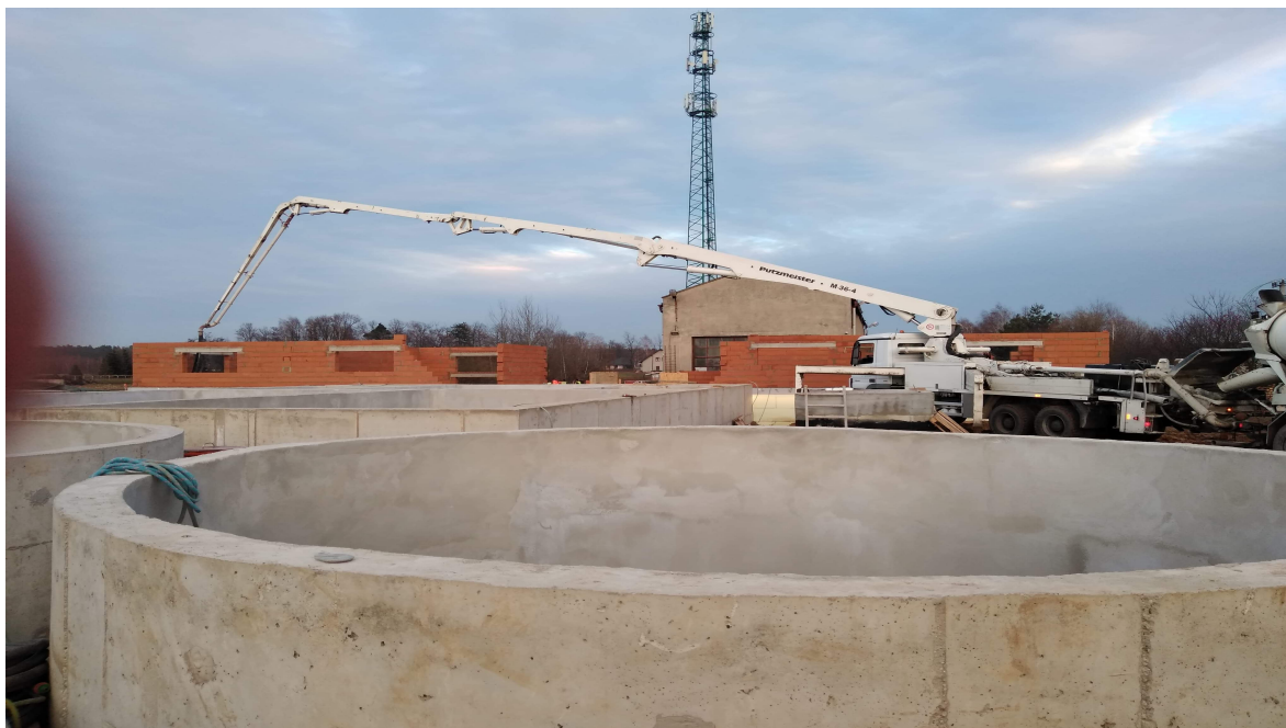
Fotografia nr 27 Rozbudowa i przebudowa oczyszczalni ścieków w miejscowości Brzeziny
