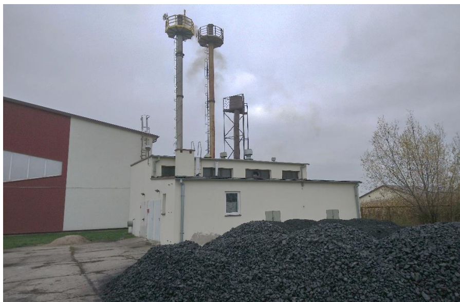
Fot. 3. Widok kotłowni i placu składowego od wschodu (listopad 2020)
