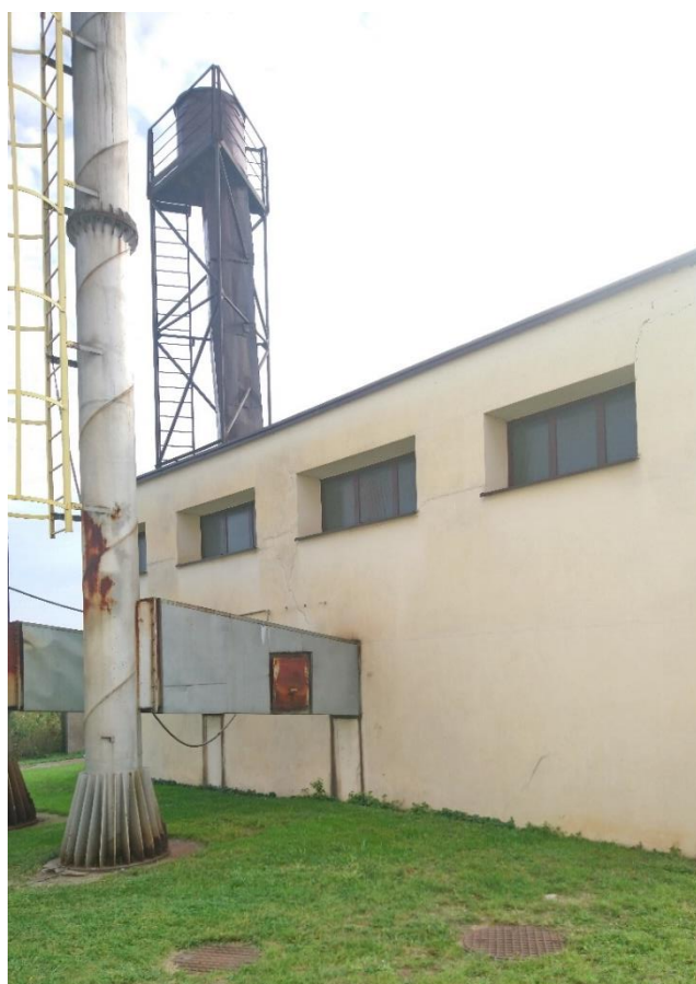
Fot. 4. Widok kotłowni od strony północno-zachodniej (listopad 2020)
