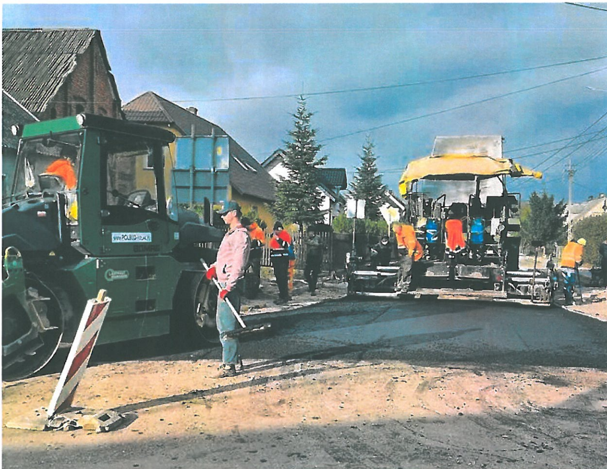
Modernizacja drogi gminnej 52/1 w miejscowości Sławsko Dolne
