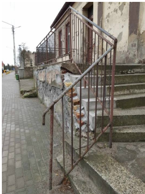
Fot. 19 Istniejąca balustrada schodowa do wymiany (elewacja frontowa)
