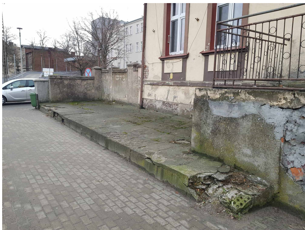
Fot. 22 Istniejący podest betonowy do rozbiórki
