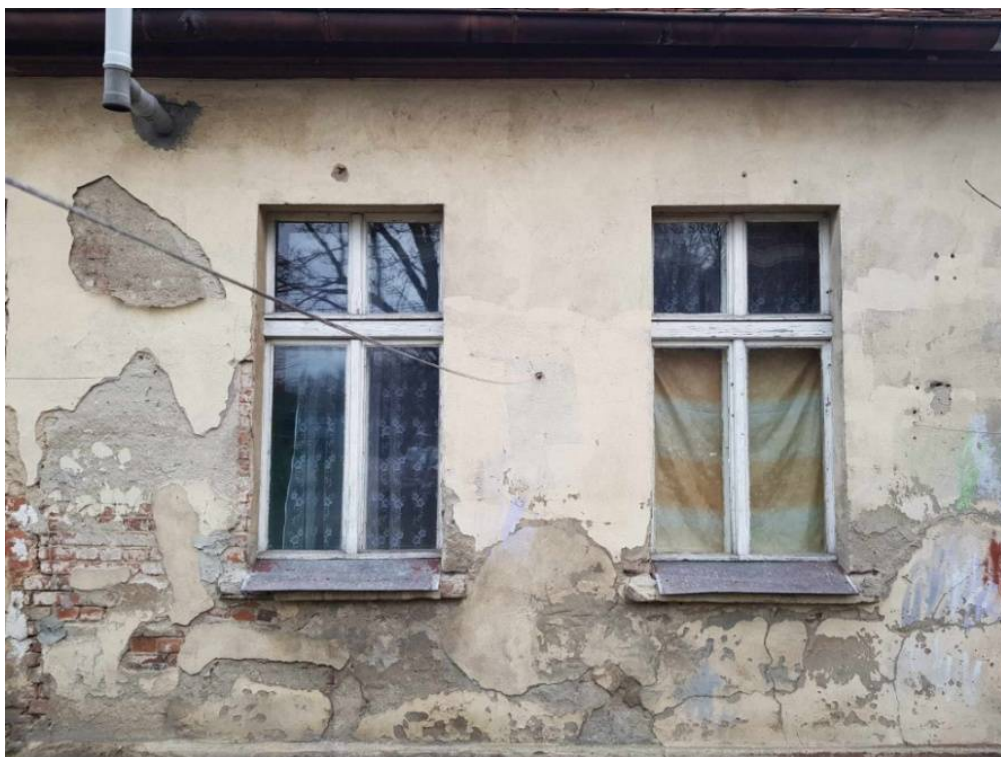
Fot. 15 Drewniana stolarka okienna do wymiany – elewacja tylna
