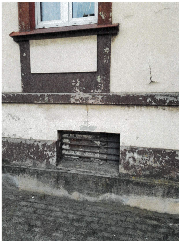
Fot. 30 Otwór okienny do piwnicy – do zamurowania
