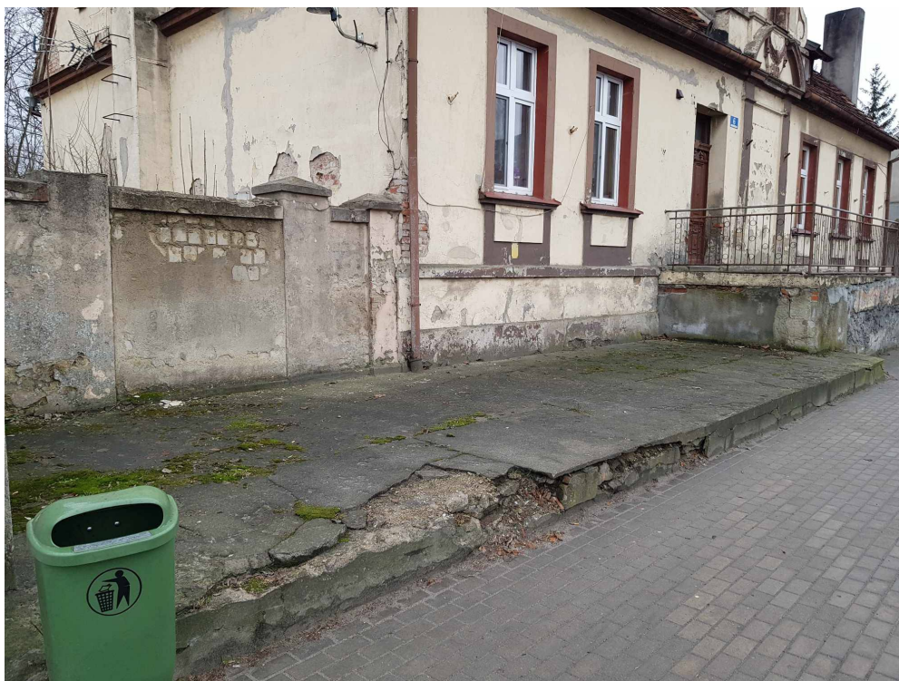
Fot. 21 Istniejący podest betonowy do rozbiórki
