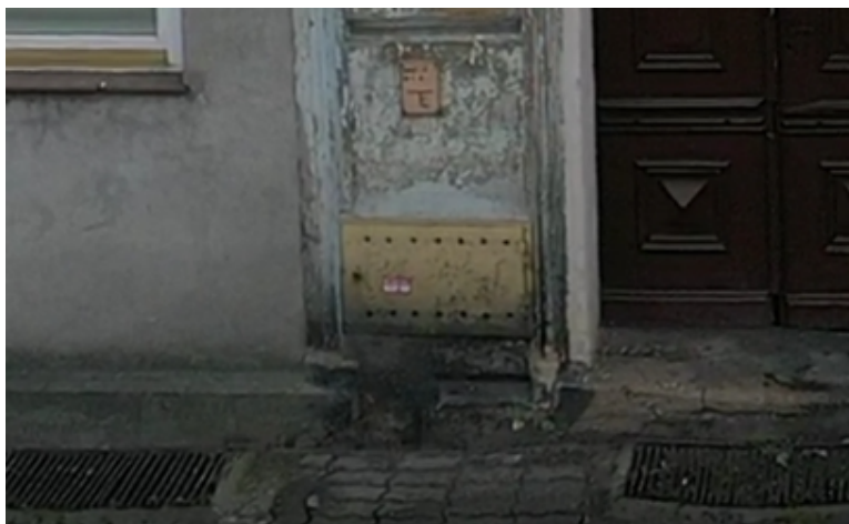
Fot. 13 Drzwiczki rewizyjne (maskownica) do wymiany
