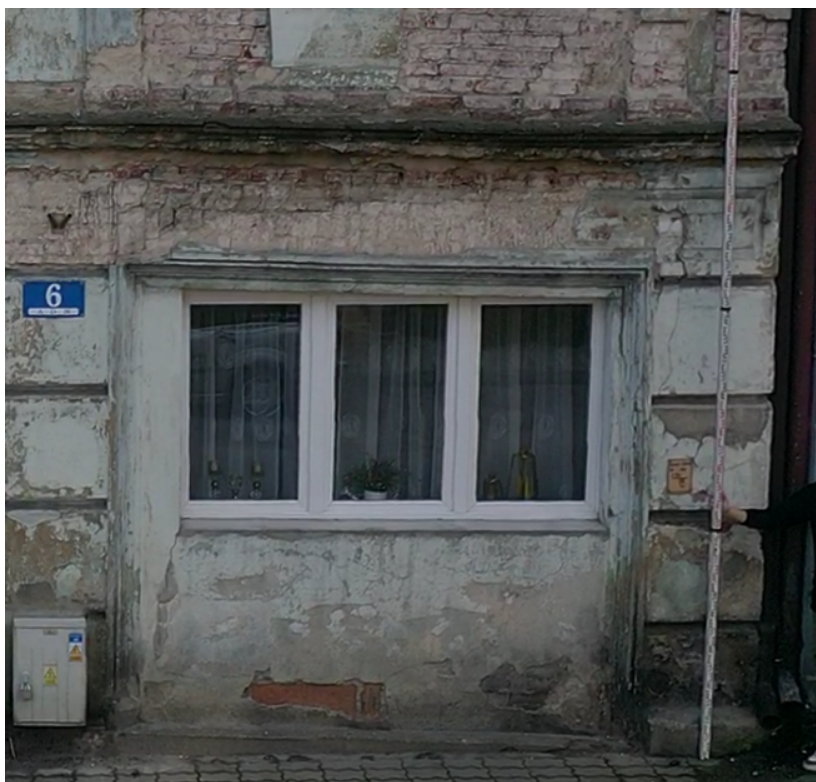
Fot. 7 Nierówności zdobień architektonicznych występujące na elewacji
