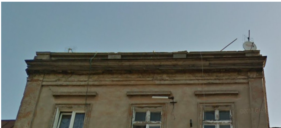
Fot. 8 Archiwalne zdjęcie gzymsu nad II piętrem (obecnie gzyms zdemontowany)
