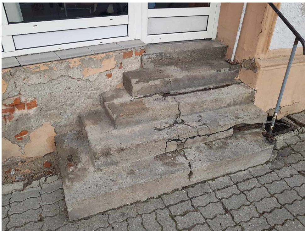
Fot. 14 Schody prowadzące do lokalu usługowego (oraz poręcz schodowa do wymiany)
