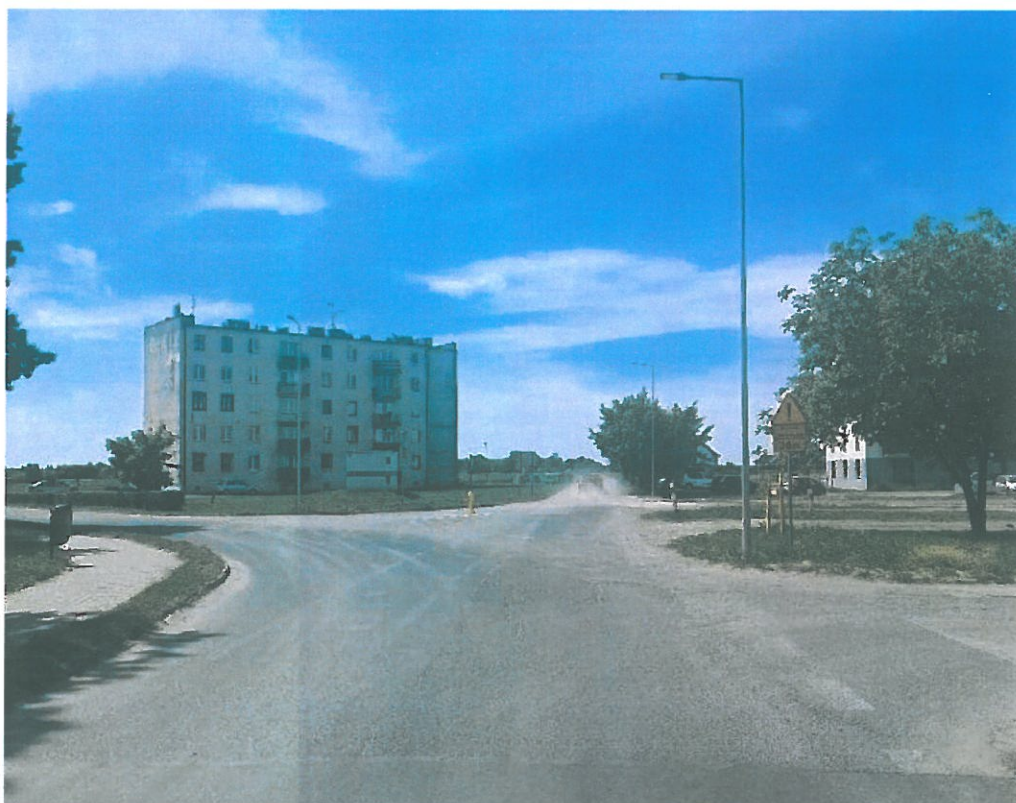
Budowa oświetlenia ulicznego na układzie skrzyżowań ul. Kasprowicza, Dąbrowskiego, W. Łokietka oraz os. Piastowskie
