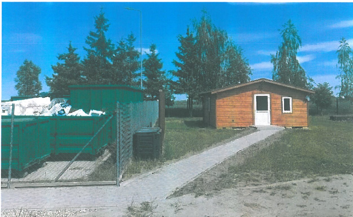
Budowa punktu selektywnego zbierania odpadów komunalnych wraz z niezbędną infrastrukturą towarzyszącą dla Gminy Strzelno
