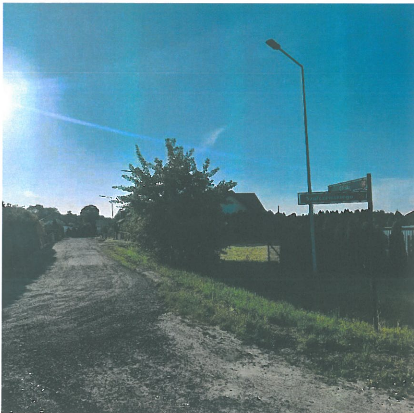
Budowa sieci elektroenergetycznej ul. Glinki w Strzelnie
