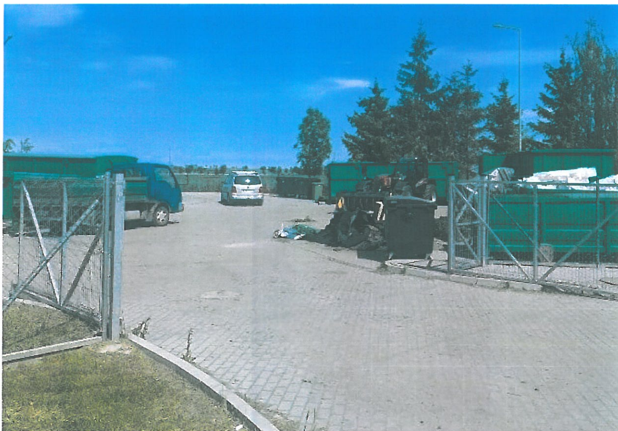
Budowa punktu selektywnego zbierania odpadów komunalnych wraz z niezbędną infrastrukturą towarzyszącą dla Gminy Strzelno
