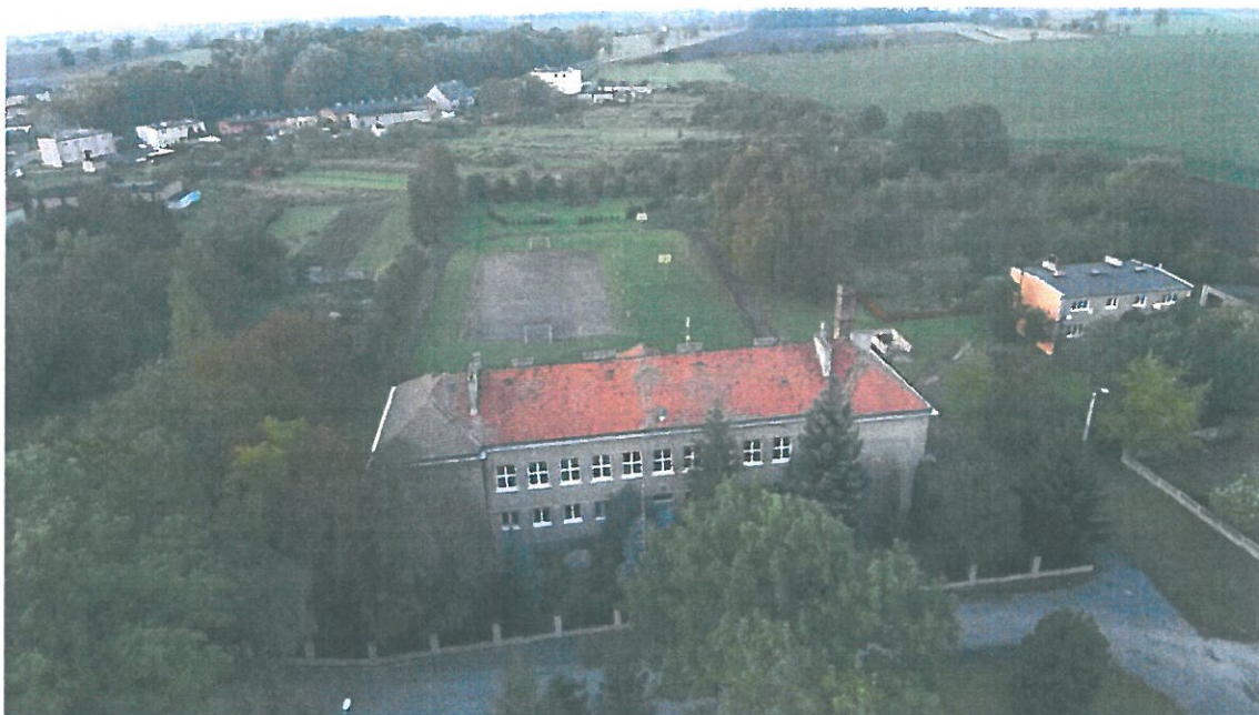
Fotografia 1: Budynek Szkoły Podstawowej w Markowicach i jej bezpośrednie otoczenie, podlegające zagospodarowaniu na cele aktywizacji społecznej
