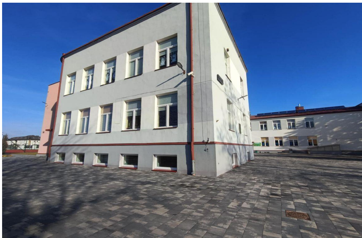
Zdjęcie 42. Wymiana nawierzchni przy Zespole Szkolno-Przedszkolnym w Starożrebach
