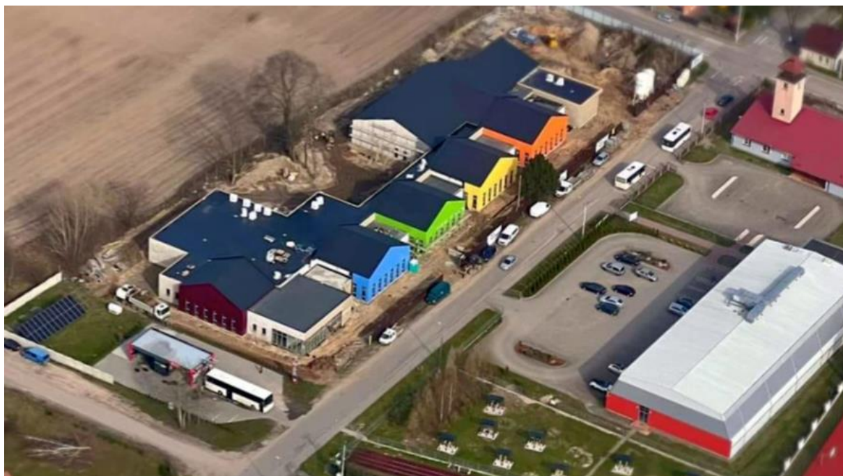
Zdjęcie 48. Budynek Kompleksu Kulturalno - Oświatowego z przedszkolem, żłobkiem wraz z Gminną Biblioteką Publiczną w miejscowości Staroźreby
