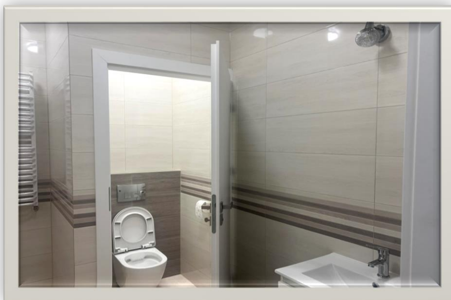
Zdjęcie 18. Remont łazienek w OSP Nowa Góra
