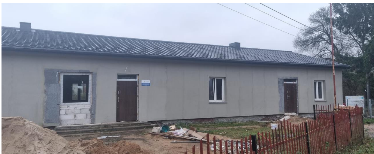
Zdjęcie 26. Przebudowa świetlicy w Rogowie
