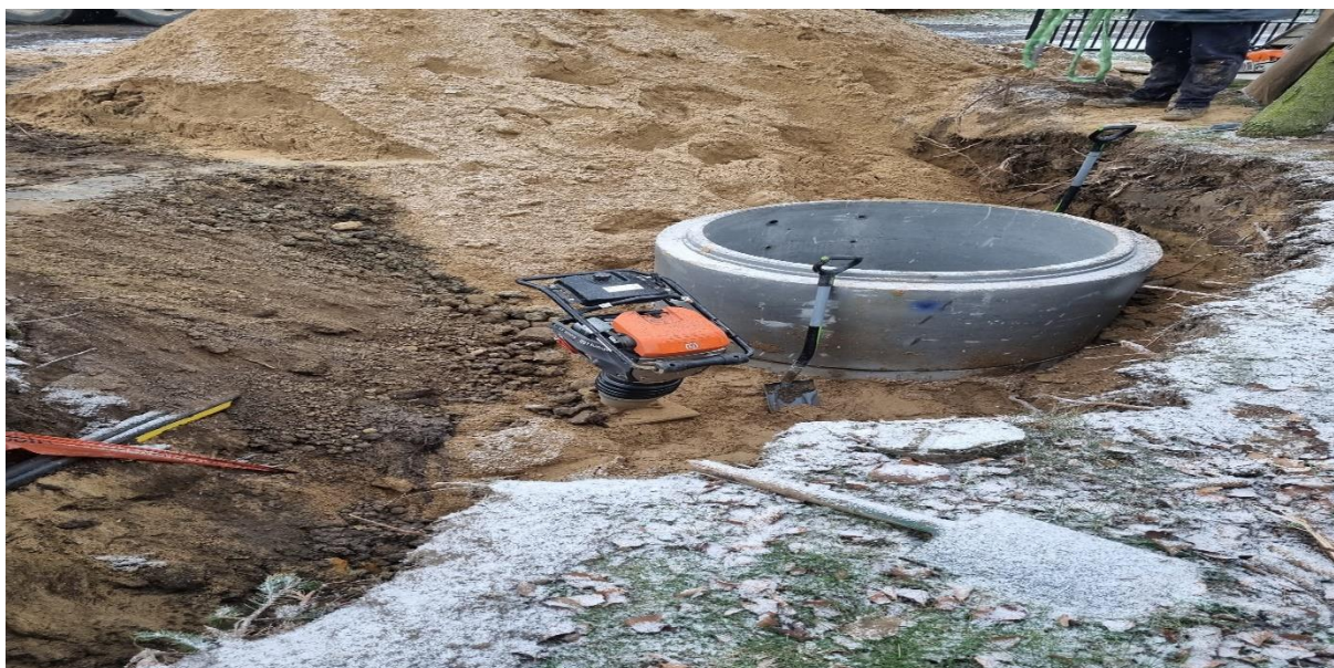
Zdjęcia 14. Rozbudowa kanalizacji i sieci wodociągowej
