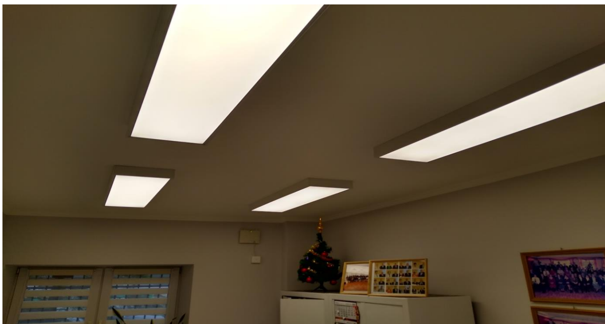
Zdjęcie 27. Wymiana oświetlenia w budynkach użyteczności publicznej
