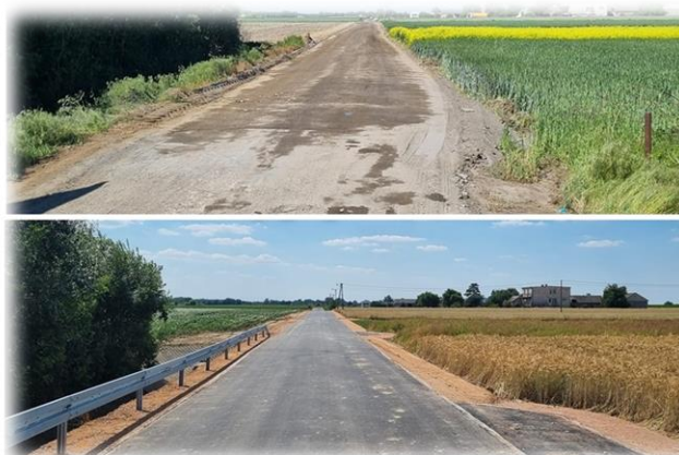
Zdjęcie 2. Budowa drogi w Żochowie Starym
