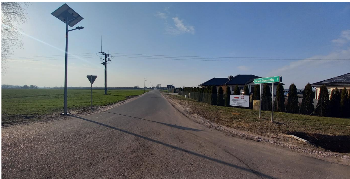
Zdjęcie 43. Oświetlenie dróg na terenie Gminy Staroźreby.
