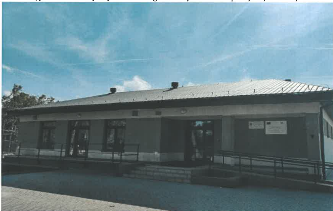
Zdjęcie 14: Zmiana pokrycia dachowego na budynku świetlicy wiejskiej w Nowej Wsi
