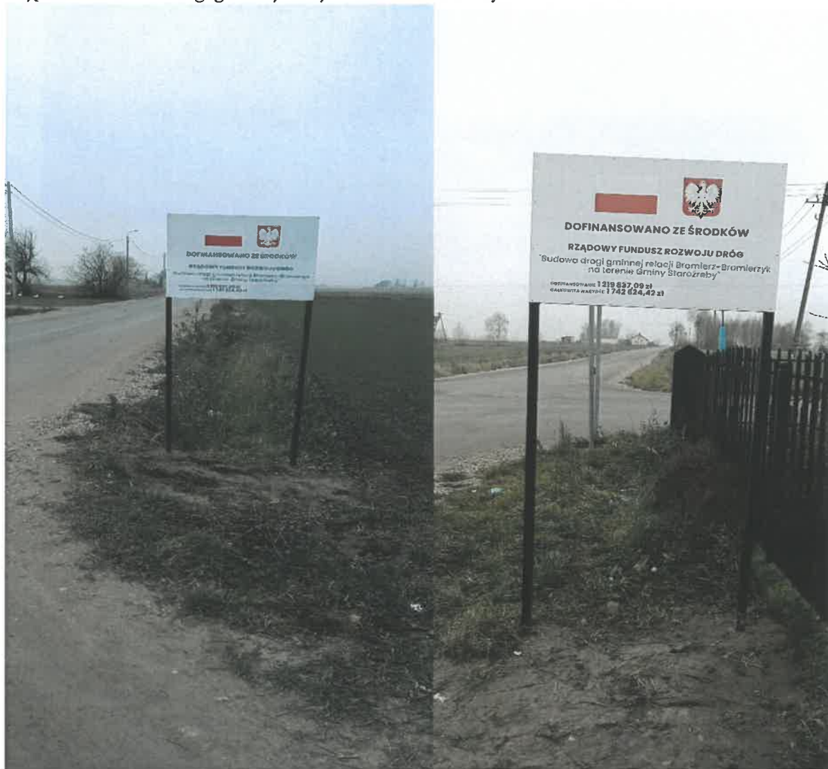
Zdjęcia 7-8: Budowa drogi gminnej relacji Bromierz- Bromierzyk
