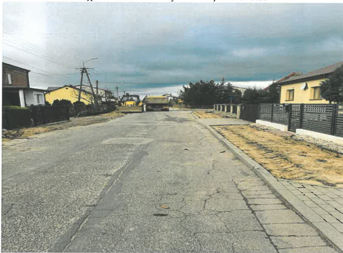
Zdjęcia 28-29: Remont ulicy Strażackiej w Staroźrebach
