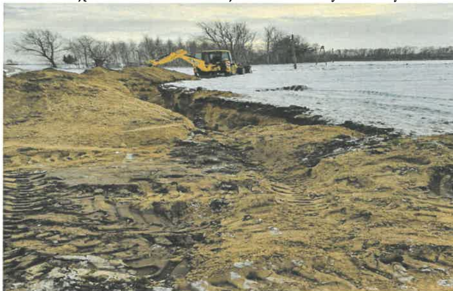
Zdjęcie 26: Budowa kanalizacji na terenie Gminy Staroźreby
