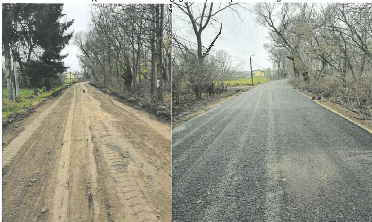
Zdjęcia 9-11: Budowa drogi gminnej w miejscowości Rogowo
