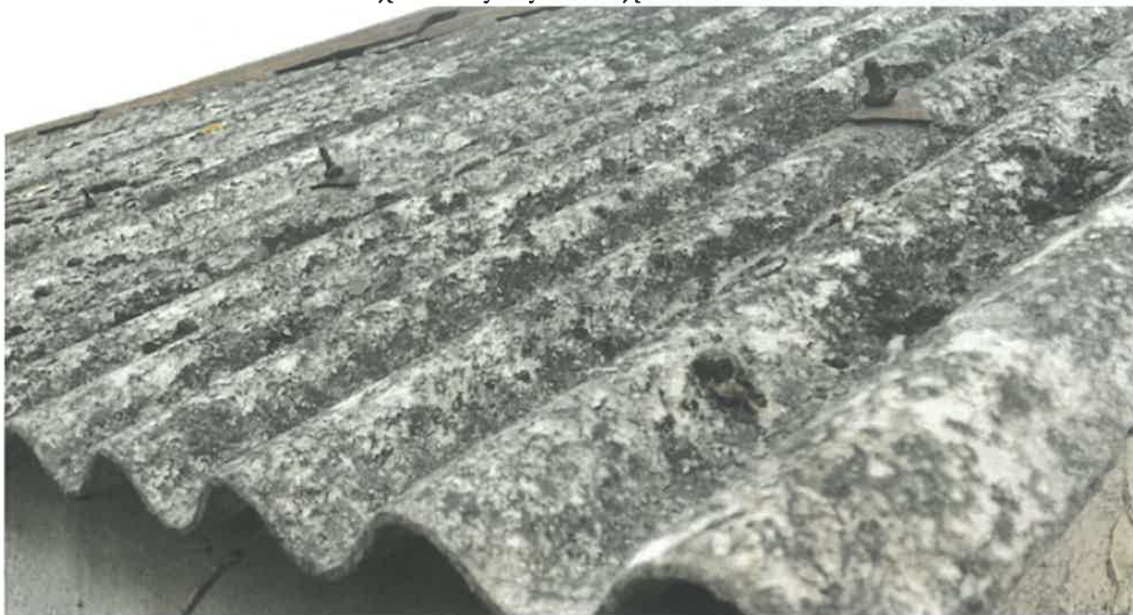
Zdjęcie 13: Wyroby zawierające azbest
