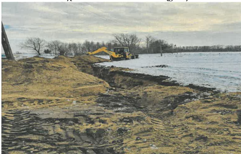
Zdjęcie 27: Budowa sieci wodociągowej
