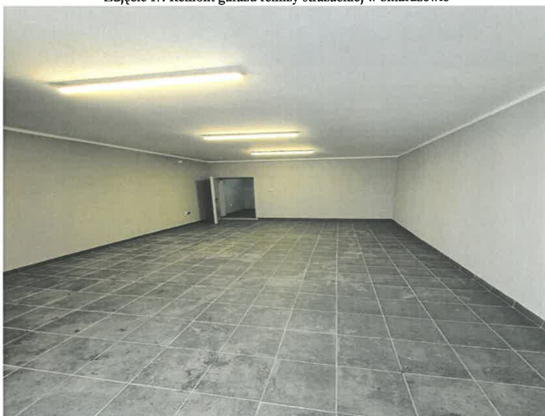
Zdjęcie 17: Remont garażu remizy strażackiej w Smardzewie
