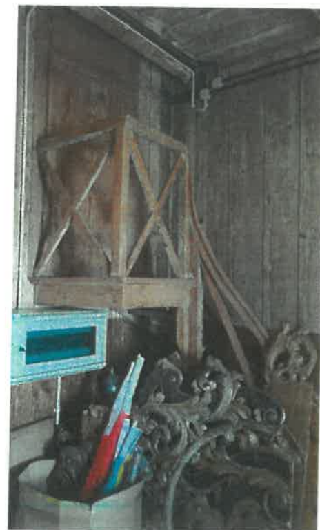
fot. 35 Kościół pw. św. Marcina w Linówcu wnętrze kościoła -schody na ambonę przeznaczone do kompleksowej konserwacji
