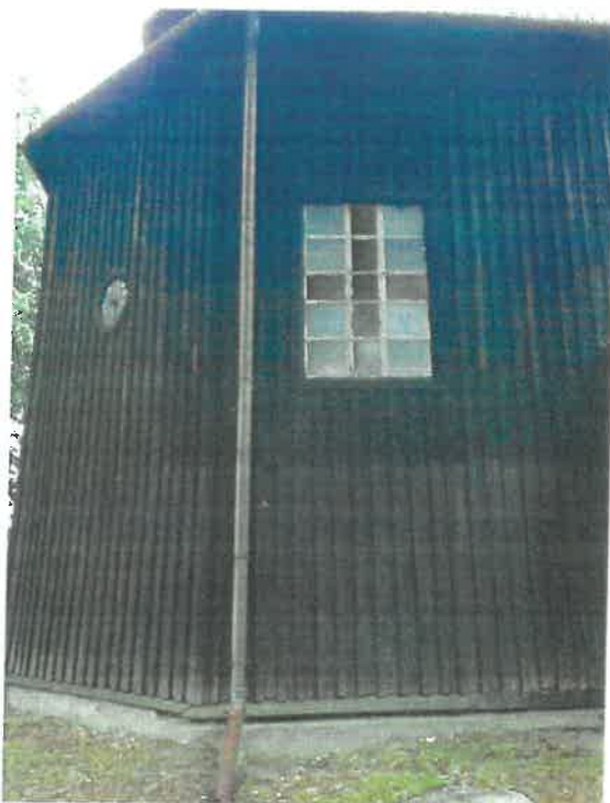
fot. 9 Kościół pw. św. Marcina w Linówcu widok na stolarkę okienną
