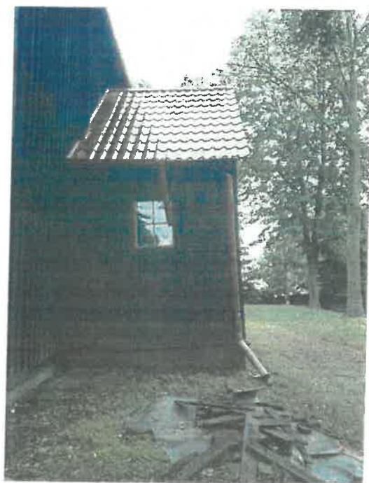
fot. 13 Kościół pw. św. Marcina w Linówcu widok stolarki okiennej Kaplicy oraz uszkodzeń systemów rynnowyc
