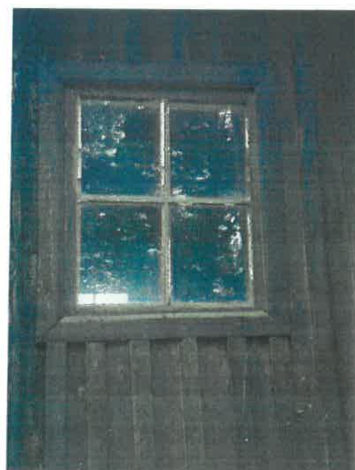
fot. 25 Kościół pw. św. Marcina w Linówcu istniejąca stolarka okienna(Kaplica)
