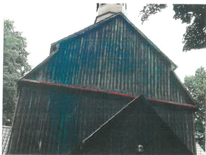
fot. 3 Kościół pw. św. Marcina w Linówcu detal deskowania ściany szczytowej w obrębie elewacji frontowej
