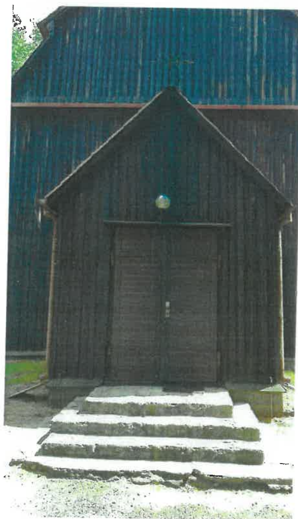
fot. 6 Kościół pw. św. Marcina w Linówcu widok drzwi prowadzących do Kruchty
