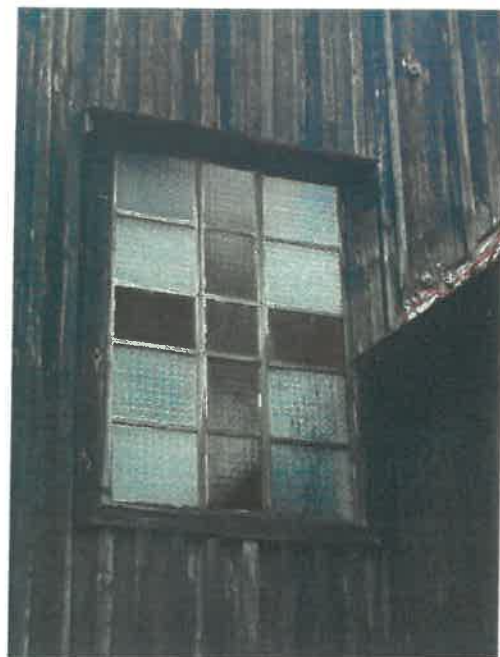
fot. 22 Kościół pw. św. Marcina w Linówcu istniejąca stolarka okienna(nawa główna)
