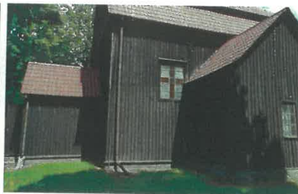
fot. 5 Kościół pw. św. Marcina w Linówcu detal deskowania ściany szczytowej w obrębie elewacji bocznej
