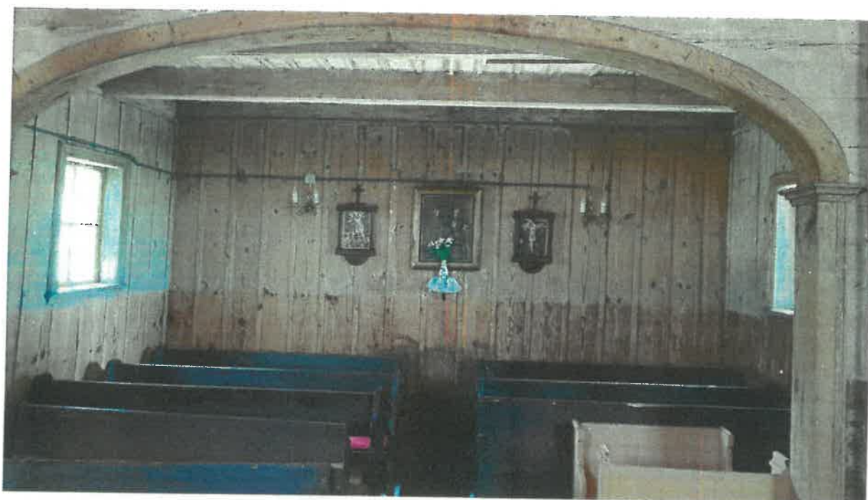
Fot. 31 Kościół pw. św. Marcina w Linówcu wnętrze kościoła – Kaplica, widoczne deskowanie do usunięcia
