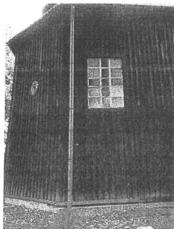
fot. 9 Kościół pw. św. Marcina w Linówcu widok na stolarkę okienną
