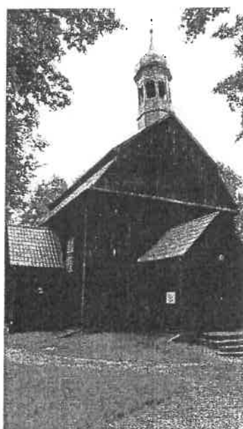
fot. 2 Kościół pw. św. Marcina w Linówcu elewacja frontowa
