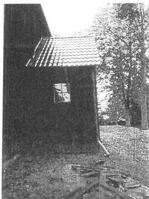
fot. 13 Kościół pw. św. Marcina w Linówcu widok stolarki okiennej Kaplicy oraz uszkodzeń systemów rynnowych
