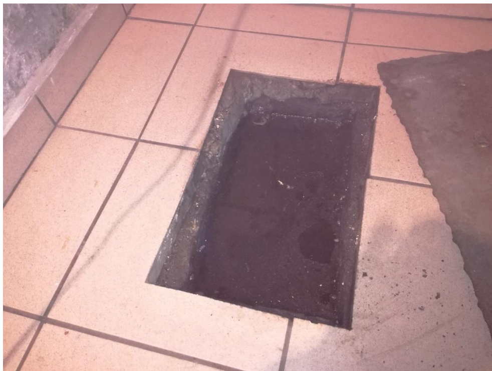
Fot. 4 Widoczny poziom wód gruntowych w studziencie rewizyjnej.
