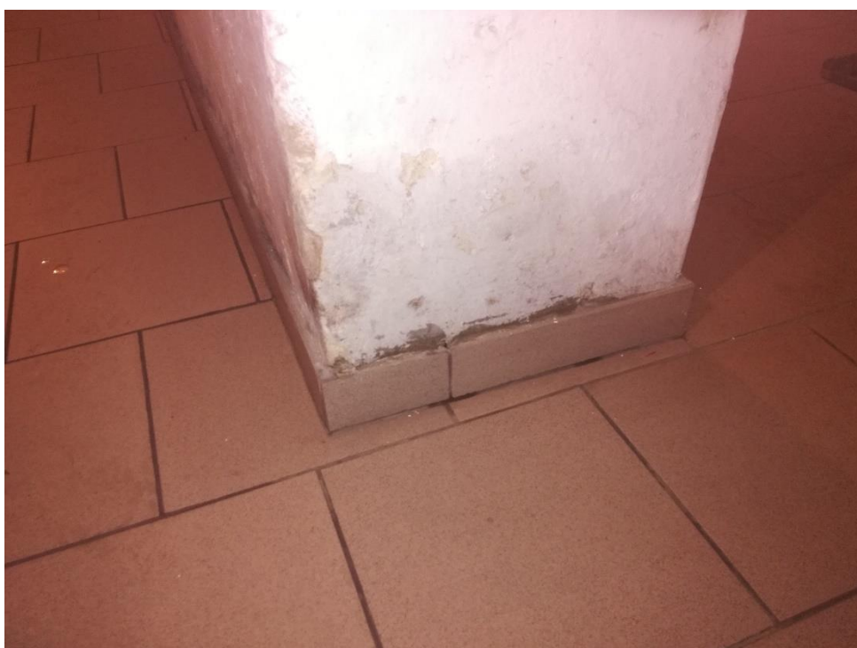
Fot. 5 Widoczne zawilgocenia tynków w piwnicy
