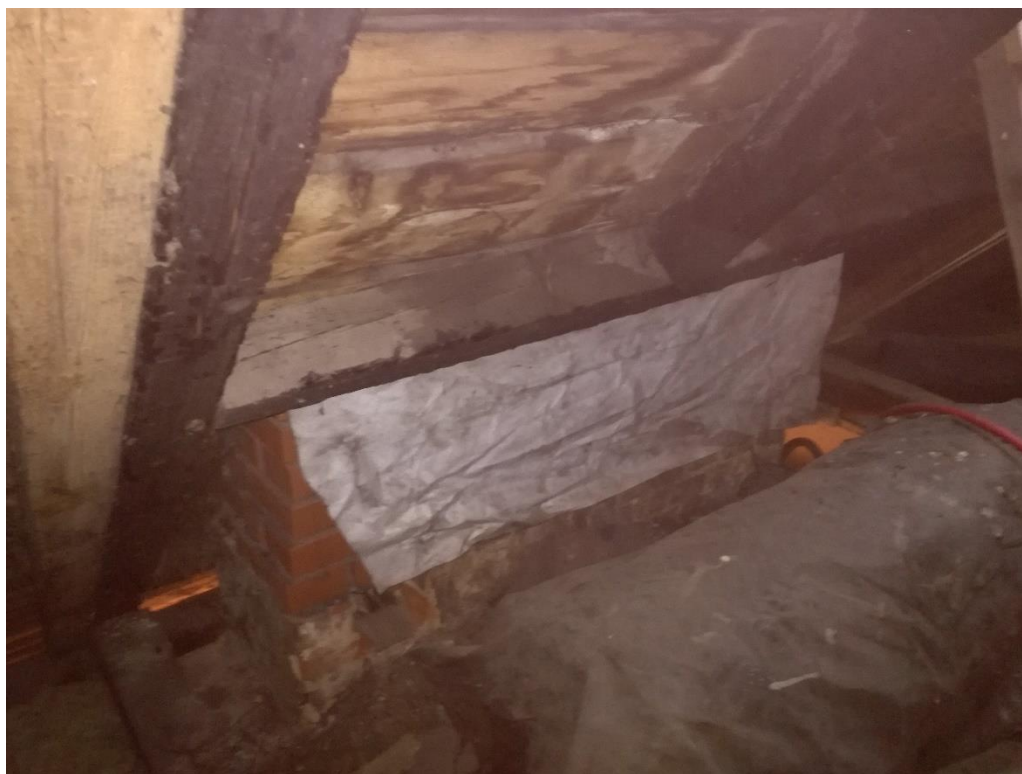
FOT. 2 widoczne nadpalenie elementów więźby w sąsiedztwie przewodu kominowego
