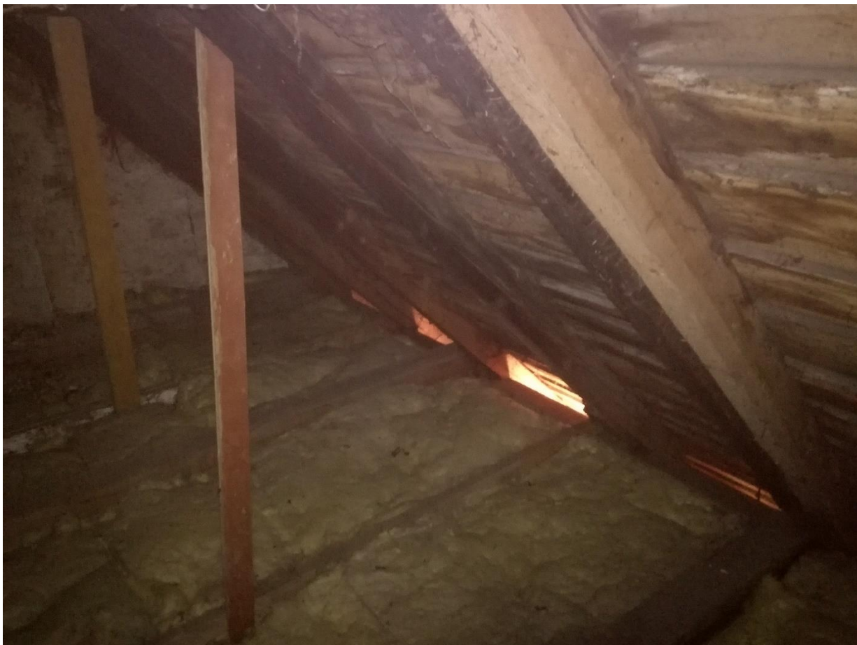
FOT. 3 widoczne podwieszenie elementów stropu drewnianego do krokwi.
