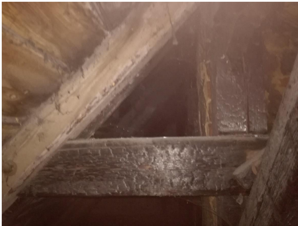
FOT. 1 widoczne nadpalenie elementów więźby
