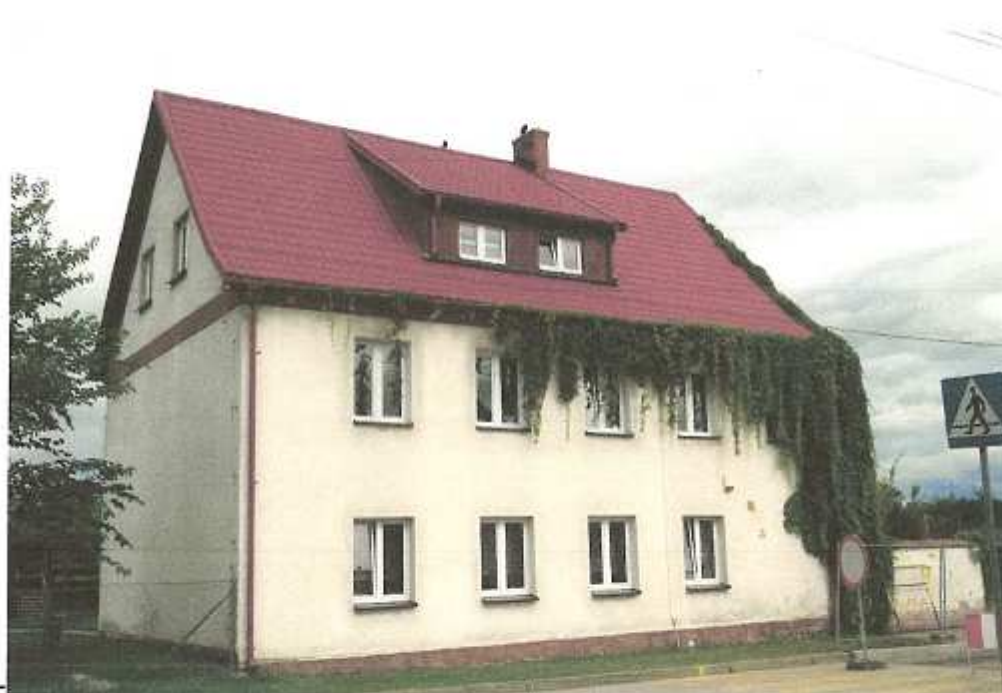
Fot. 1 Budynek Przedszkola, widok od strony południowej.
