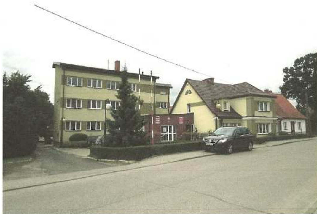
Fot. 1. Urząd Gminy w Rozogach, widok od strony ul. Kętrzyńskiego.
