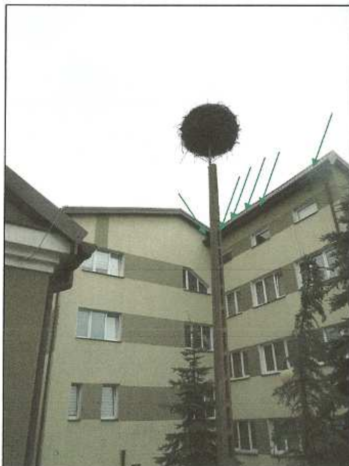
Fot. 9. Urząd Gminy w Rozogach – elewacja północna (skrzydło zachodnie). Lokalizacja miejsc gniazdowych wróbla i jerzyka.
