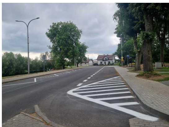
Kontynuacja przebudowy drogi wojewódzkiej w Brzuzem
