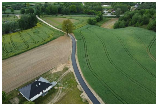
Przebudowa drogi gminnej w Okoninie
