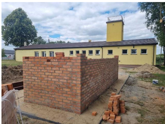
Budowa altany w Giżyńku
