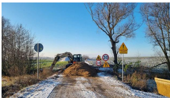
Rozpoczęcie przebudowy drogi gminnej w Dąbrówce
