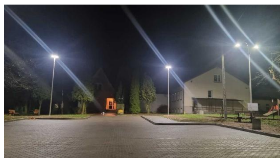
Budowa oświetlenia w Radzynie
