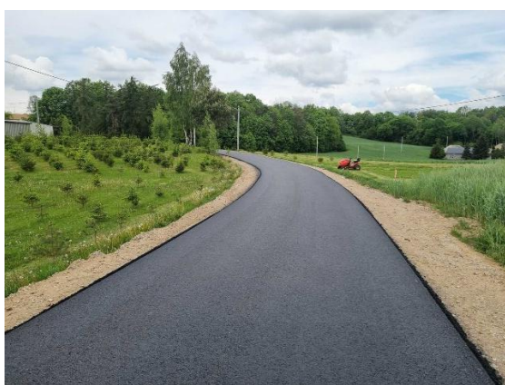
Budowa drogi gminnej Okonin-Obory
