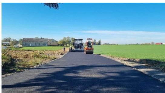
Budowa drogi Trąbin Rumunki-Radomin
