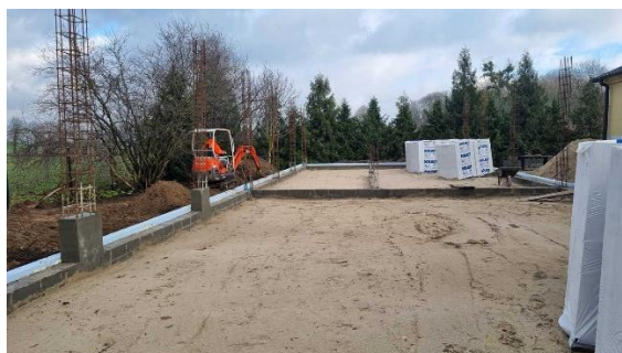
Rozbudowa świetlicy w Ugoszczu
