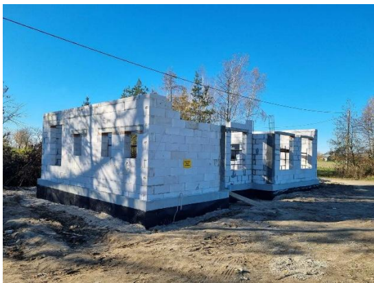
Budowa świetlicy w Przyrowie
