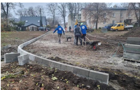
Przebudowa dróg osiedlowych w Ostrowitem
