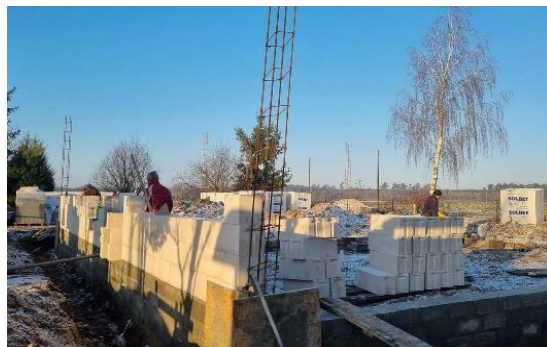
Budowa świetlicy w Trąbinie Rmunkach
