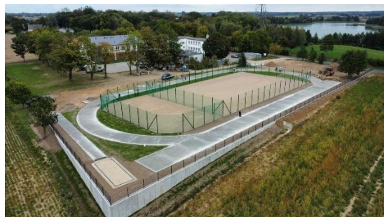
Budowa przyszłolnego kompleksu sportowego w Ugoszczu
