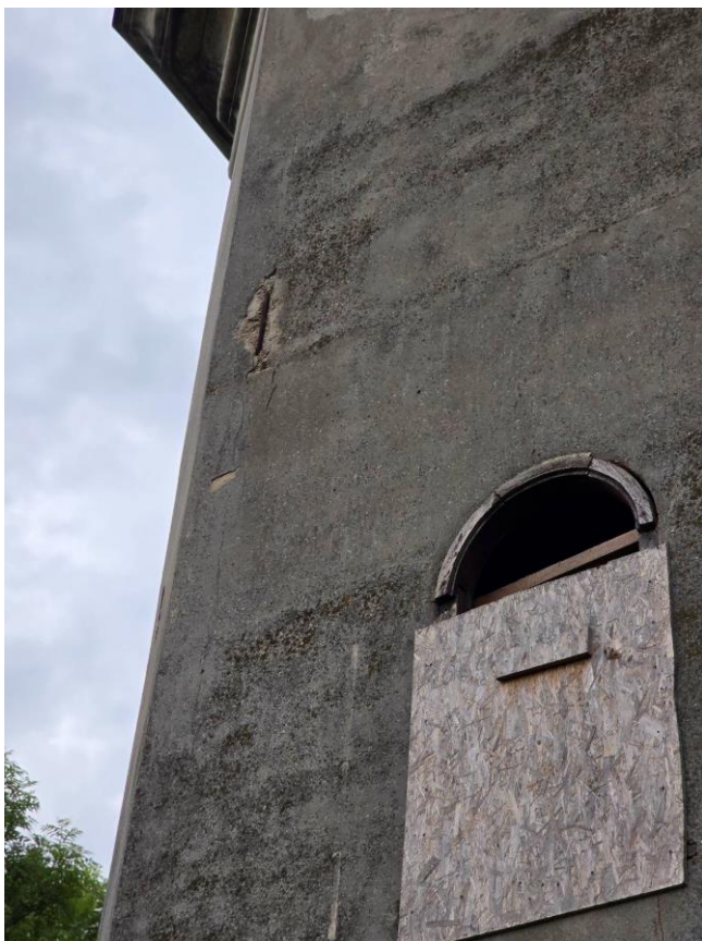
Zd.3 Widok odsłoniętego zbrojenia w ścianie wejściowej wieży
