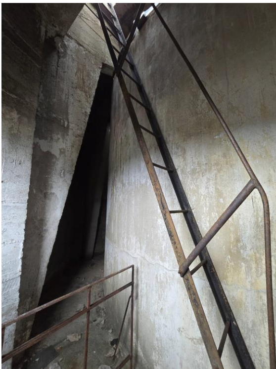
Zd.20 Drabiny stalowe techniczne na dach i na strop zbiornika z pomostu technicznego
