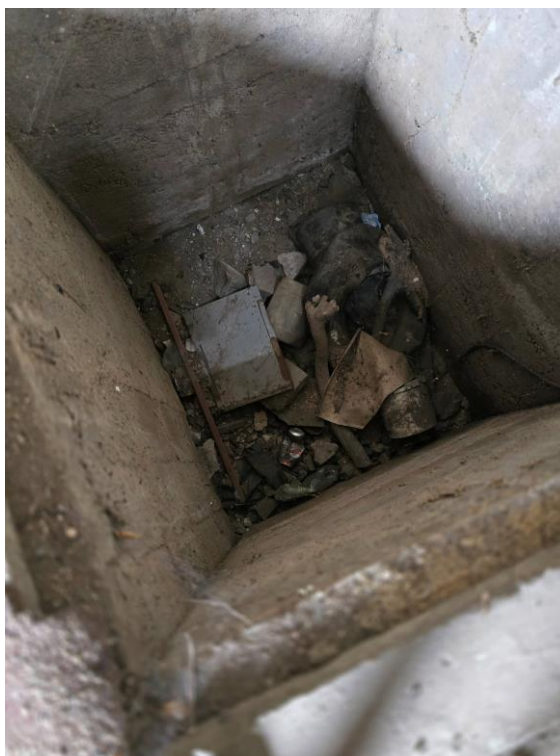
Zd.17 Kanał techniczny w przyziemiu, otwarty ,niezabezpieczony
