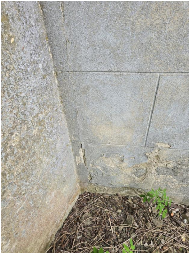
Zd.2 Widok odspojonych tynków na zewnętrznych ścianach
