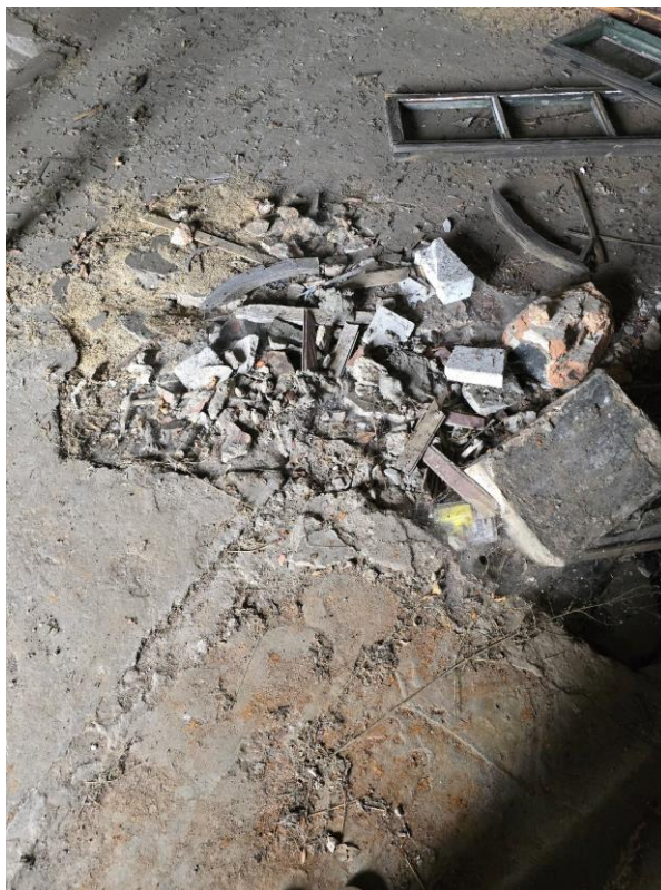
Zd.16 Uszkodzenia posadzki betonowej
