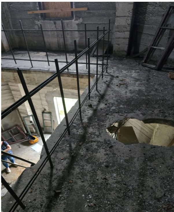
Zd.10 Widok otworu z wystającym zbrojeniem oraz barierki z prętów
