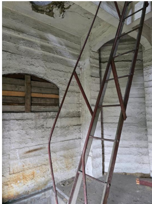
Zd.20 Drabiny stalowe techniczne na poziom stropu zbiornika
