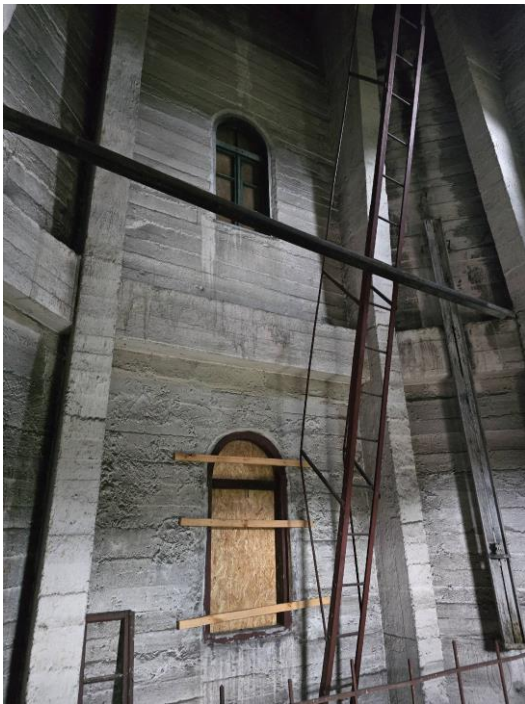
Zd.20 Drabiny stalowe techniczne na poziom stropu zbiornika
