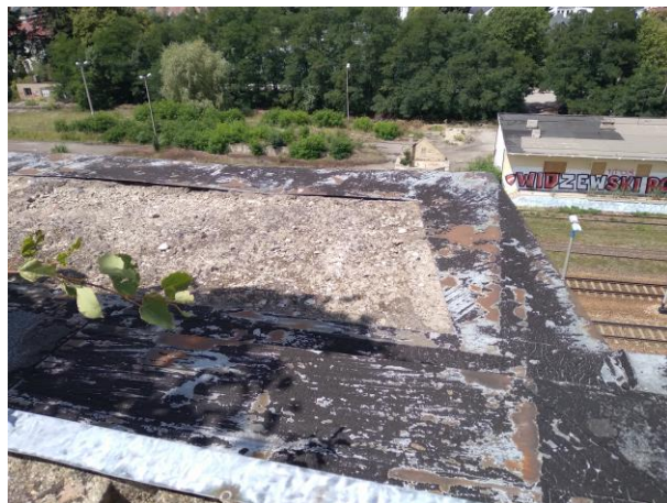
7. Uszkodzone obróbki blacharskie i pokrycie z papy.
