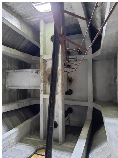
5. Belki żelbetowe na pomoście technicznym.
