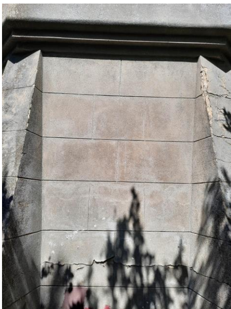
2. Boniowanie na ścianie cokołu.
