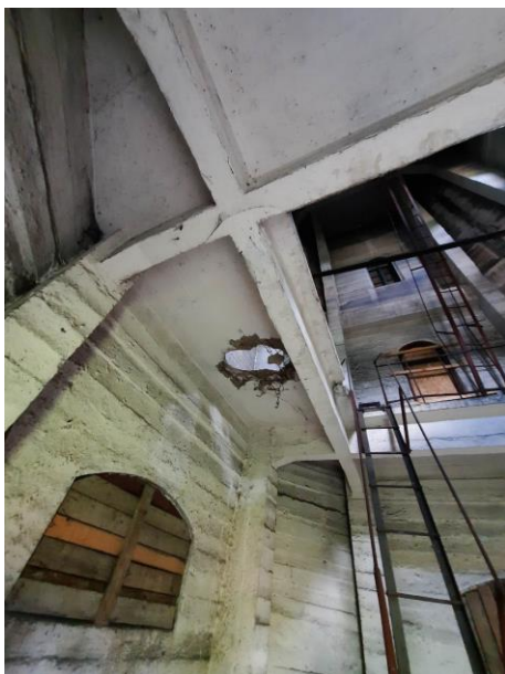
4. Belki żelbetowe podpierające strop poziomu+1.
