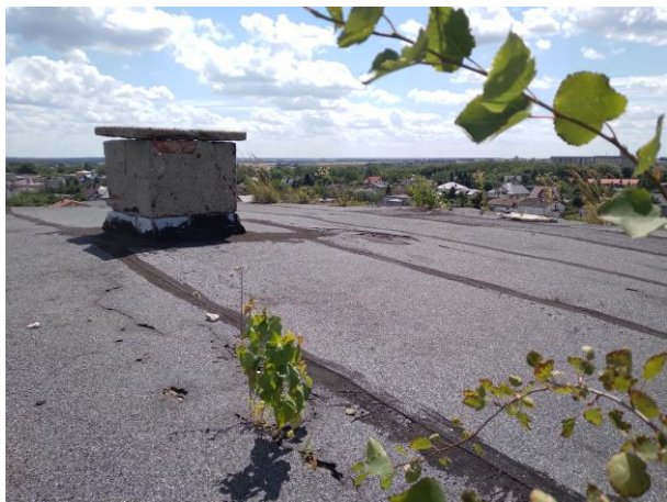
6. Kominek wentylacyjny i uszkodzone pokrycie z papy.
