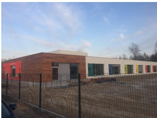
Widok elewacji południowej budynku przedszkola.
