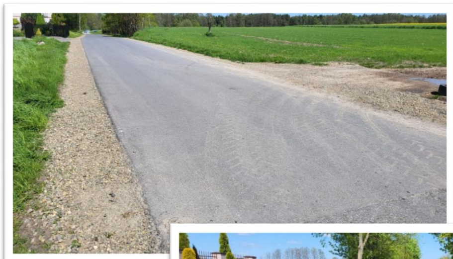
Wyremontowany odcinek drogi masą mineralno-bitumiczną w Niwie Odechowskiej
