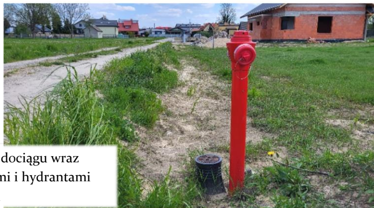
Odcinek wodociągu wraz z przyłączami i hydrantami w Makowie
