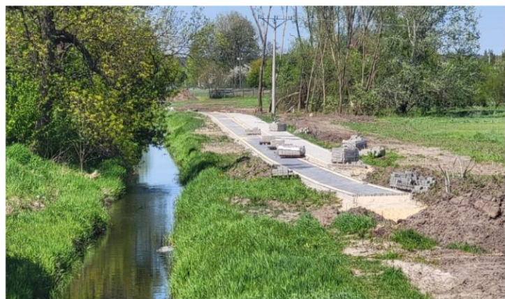
Jesienią 2022 roku rozpoczęła się budowa Bulwarów nad rzeką Kobylanką w Skaryszewie
