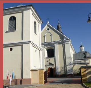
Dzwonnica przy kościele w Skaryszewie
