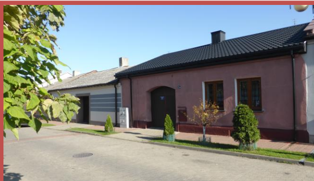
Przykłady zabudowy przy ul. Sienkiewicza w Skaryszewie
