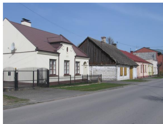
Zabudowa ul. Wyszyńskiego
