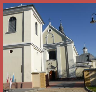
Dzwonnica przy kościele w Skaryszewie
