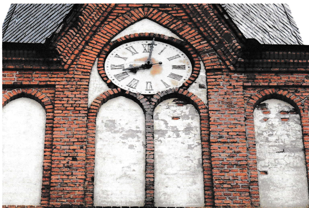
Widok elewacji zachodniej oraz zbliżenie odpadających rynków cementowych.
