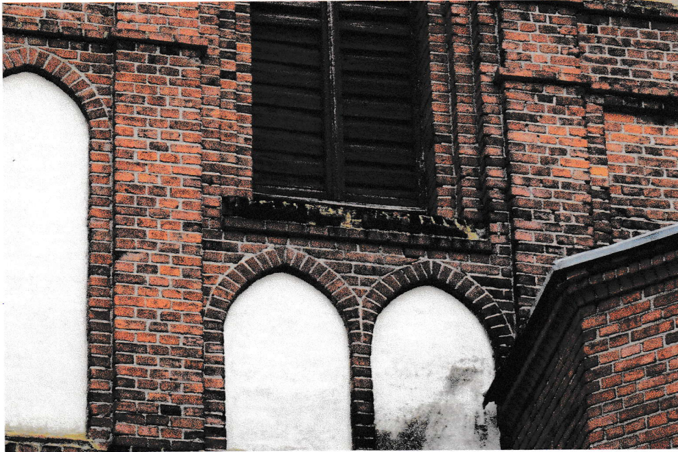
Zbliżenie uszkodzeń w partii parapetu
