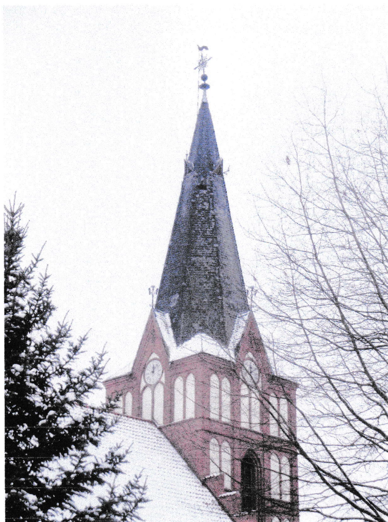
Ilustr. 5. Widok wieży od strony północno-wschodniej. Widoczne uszkodzenia i braki zdegradowanego pokrycia i detali dachu.
