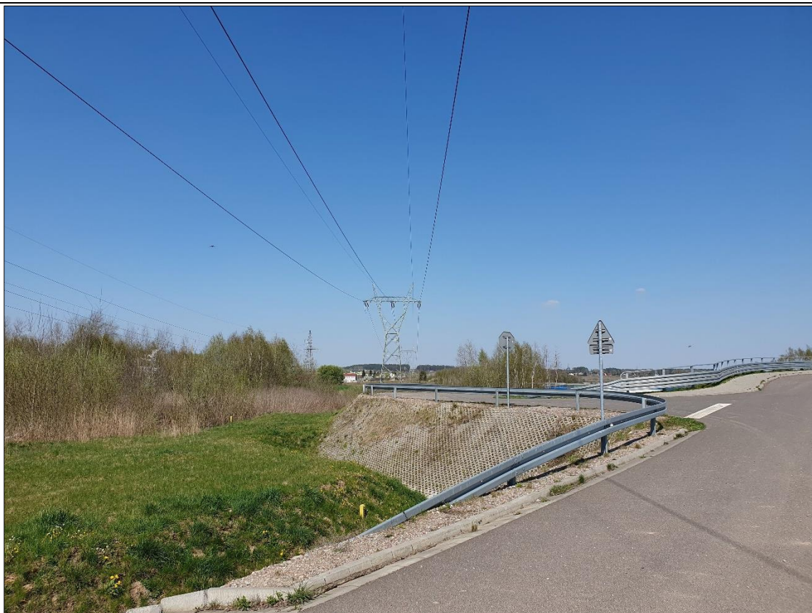
Fot. 6 Widok na projektowany obszar 2KOP przy wiadukcie (fot. własna)
