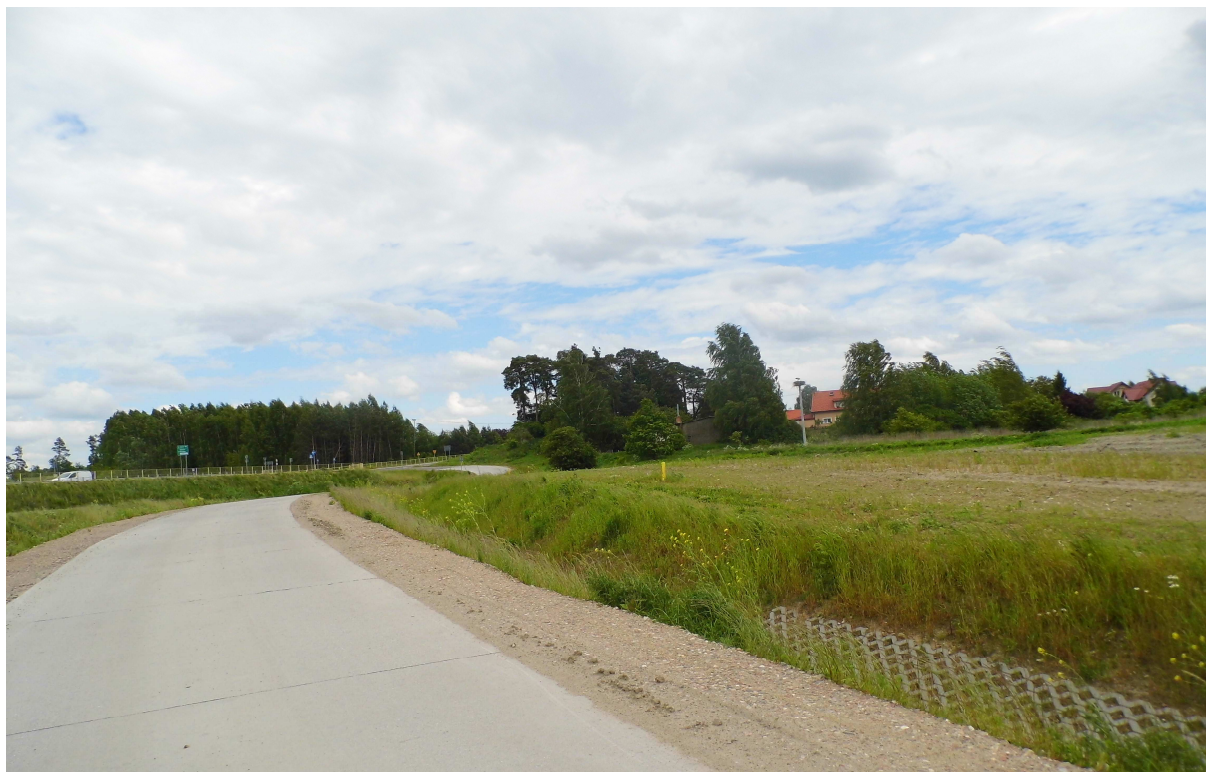
FOT 1. Teren węzła drogi ekspresowej – droga serwisowa, po stronie prawej widoczny teren opracowania po przekształceniach makroniwelacyjnych.
