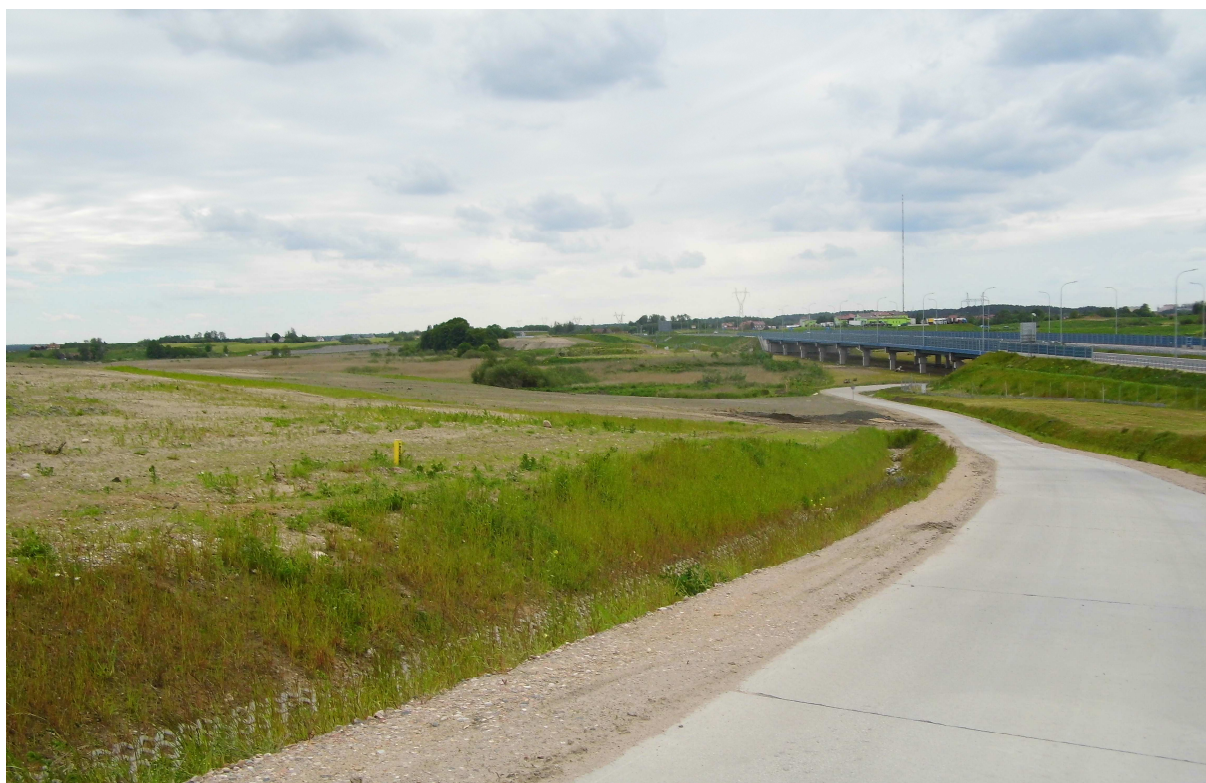
FOT 3. Teren węzła drogi ekspresowej – droga serwisowa, teren opracowania po przekształceniach makroniwelacyjnych. Jak widać teren jeszcze nie porasta żadna zieleń stąd widoczne ślady po niedawnych pracach terenowych.
