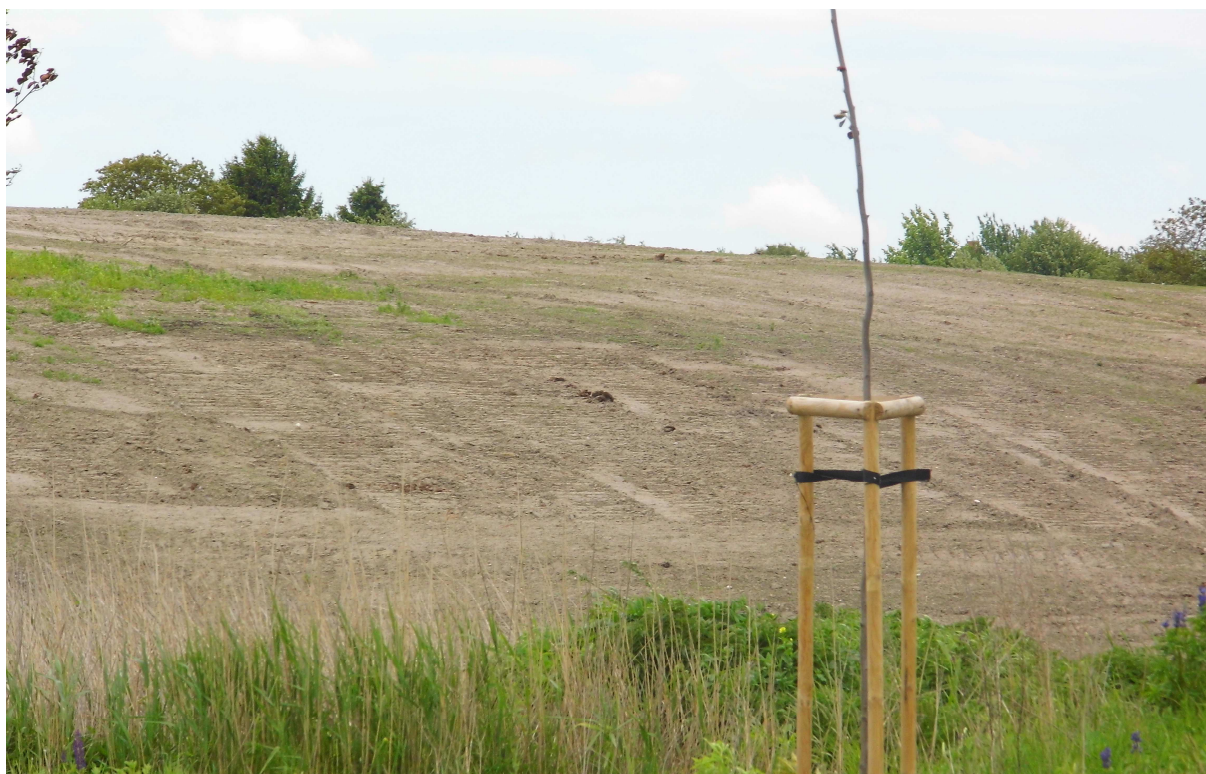
FOT 6. Teren opracowania U – po rekultywacji, widoczne ślady po niedawnych pracach ziemnych mających na celu wyrównanie i złagodzenie opadającego stoku wysoczyzny.
