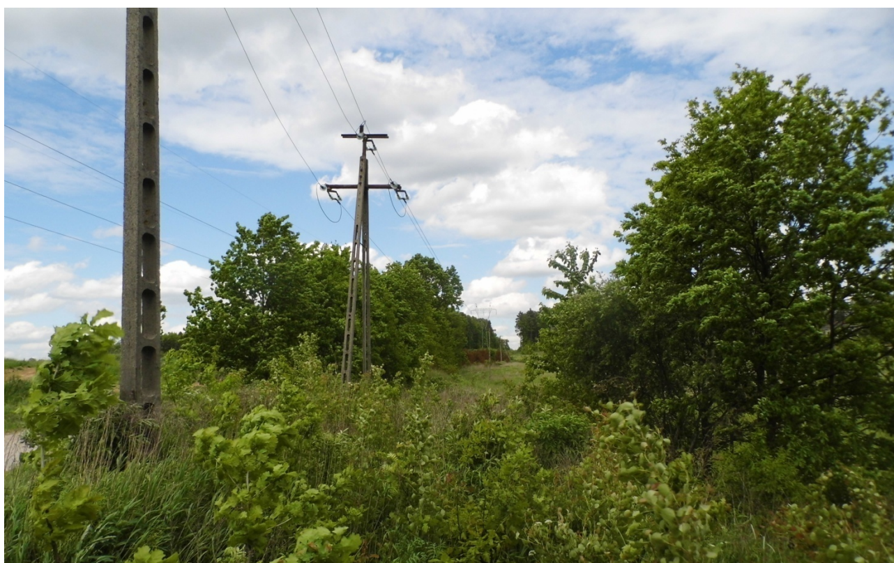
FOT 3. Granica zachodnie – widoczne sieci wysokiego napięcia po lewej i średniego napięcia centralnie.
