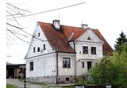
c) budynek mieszkalny w Butrynach
