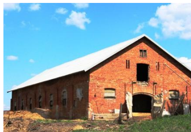
budynek obory w zespole folwarcznym w Prejłowie
