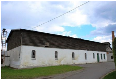
budynek mleczarni w zespole folwarcznym w Bałdach
