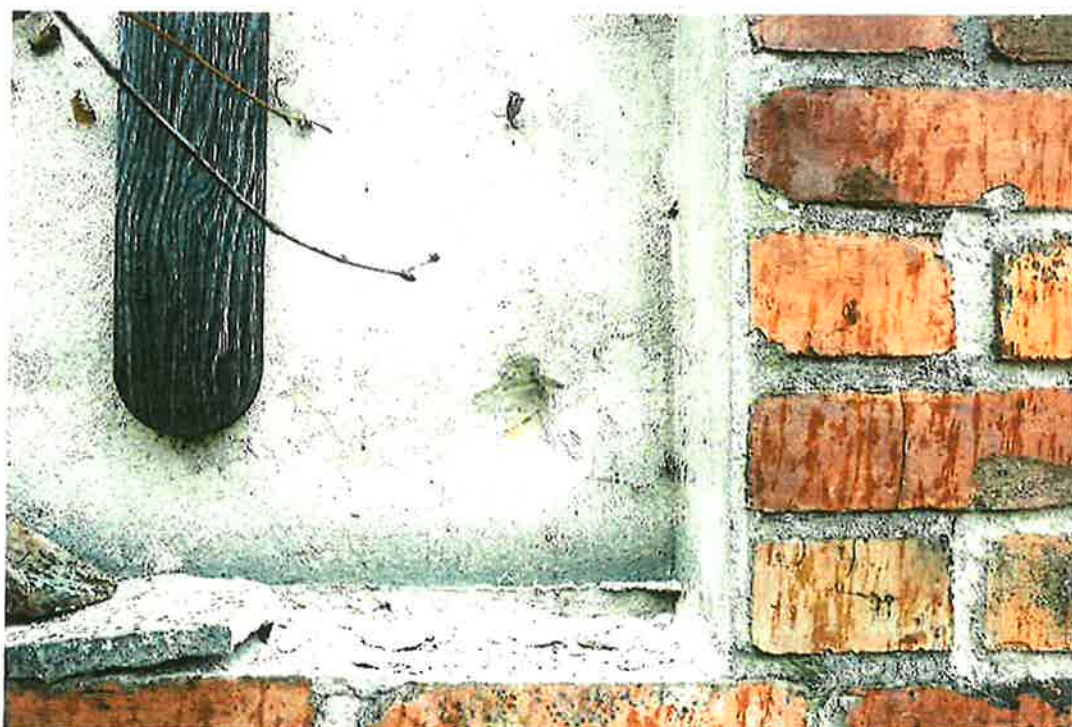
Odkrywka w blendzie od strony południowej. Zaprawa tynkarska i szlichta na powierzchni poziomej zostały wykonane bardzo mocną zaprawą cementowo-wapienną. Są to zaprawy wtórne.
