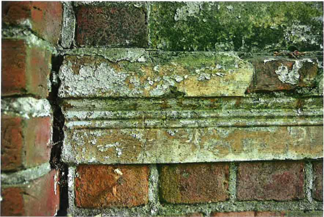
Fragment gzymsu pod blendą. Widoczne ślady oryginalnego wymalowania w kolorze jasno żółtym.
