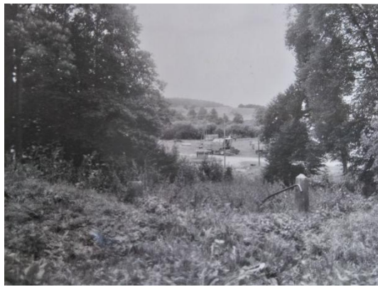
Ryc. 16. Folwark od strony południowej. Widok zza rzeki
