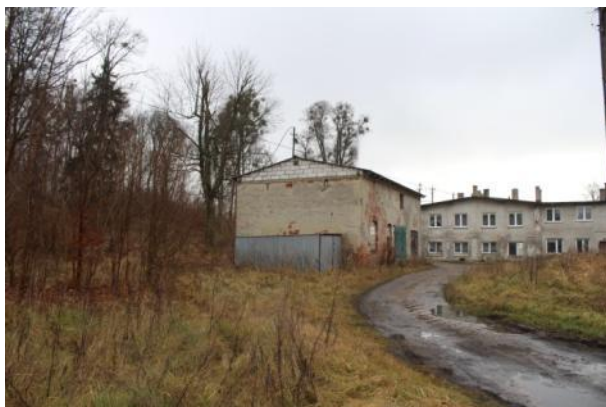
Fot. 1. Dawna zabudowa folwarczna sąsiadująca z parkiem od strony zachodniej (od lewej miejsce po kuźni, budynek gospodarczy i dawna stajnia-chlewnia), fot. M. Antolak, listopad 2016 r.
