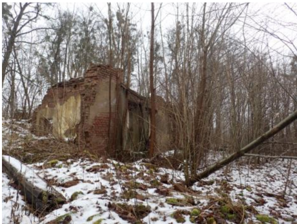
Fot. 21. Ruiny dworu, widok od strony północnej, fot. P. Pawelec, styczeń 2017 r.
