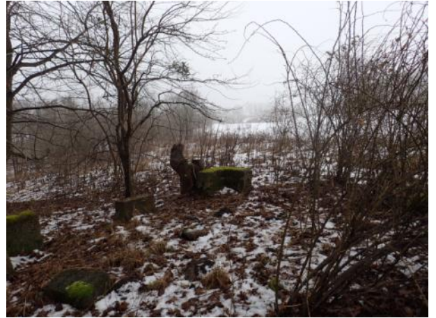
Fot. 26. Fundamenty po niezidentyfikowanym budynku w północno-wschodnim narożniku parku, fot. M. Antolak, styczeń 2017 r.
