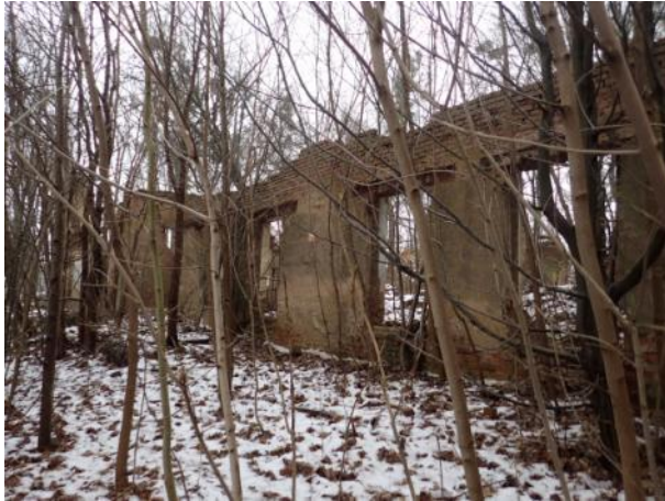
Fot. 19. Ruiny dworu, widok od strony południowej, fot. M. Antolak, styczeń 2017 r.
