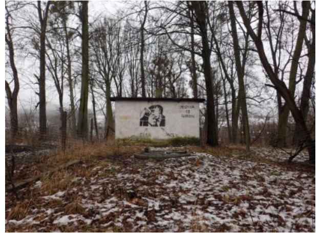
Fot. 32. Budynek dawnego ujęcia wody, widok od strony północno-wschodniej, fot. M. Antolak, styczeń 2017 r.
