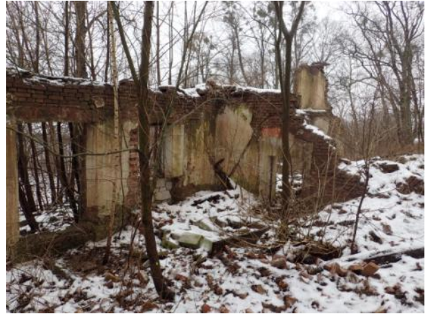
Fot. 20. Ruiny dworu, część wewnętrzna, fot. M. Antolak, styczeń 2017 r.
