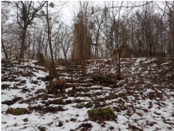
Fot. 27. Pozostałości schodów prowadzących do ruin dworu, fot. M. Antolak, styczeń 2017 r.
