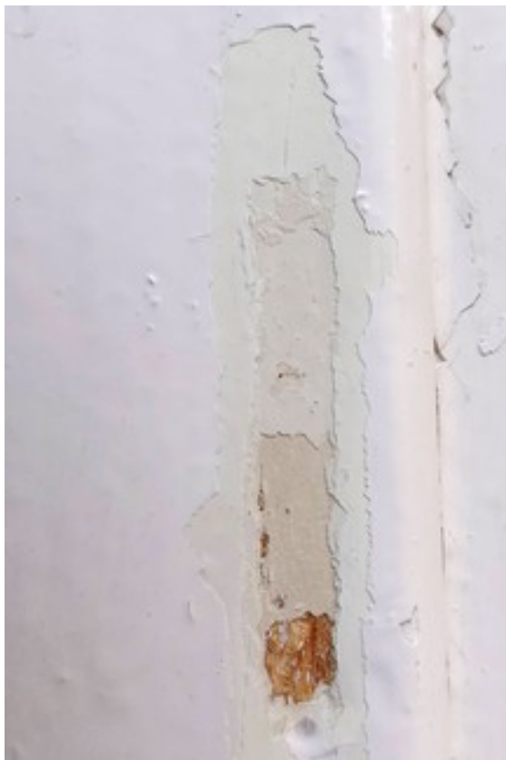
FOT.1 Układ warstw stratygraficznych od strony wewnętrznej skrzydła okiennego . W warstwie pierwotnej tylko drewno bez warstwy malarskiej. Brak również drugiej warstwy hist. w kolorze ciepłej bieli. Sonda rozpoczyna się od trzeciej w-wy hist.
