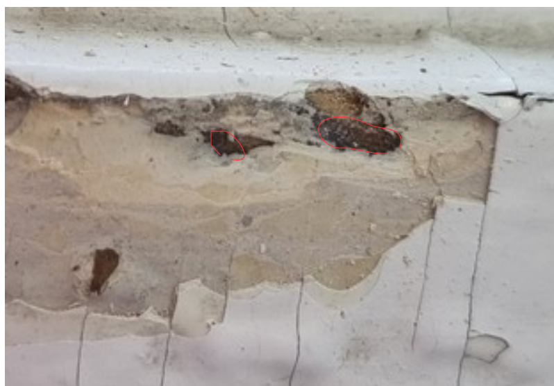
FOT.5 Zakreślono ciemnobrązowy kolor oryginalnego wymalowania wewnętrznej strony okien parteru strony zachodniej
