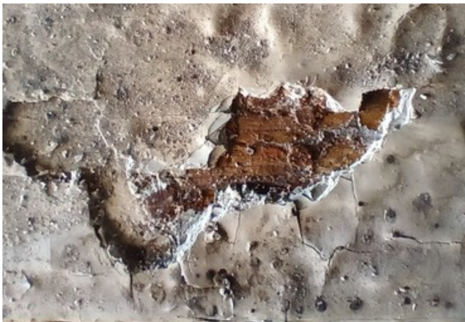
FOT.6 Zbliżenie na część zewnętrzną okna poddasza elewacji wschodniej. Widoczne resztki ciemnobrązowego koloru pierwotnego leżące bezpośrednio na drewnie okna.
