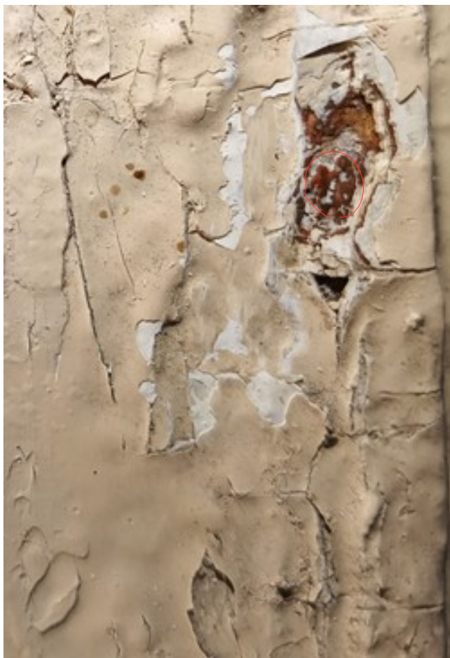
FOT.4 Czerwienią zakreślono resztki ciemnobrązowej oryginalnej warstwy historycznej . Strona zewnętrzna okna przy połaci dachu od strony wschodniej
