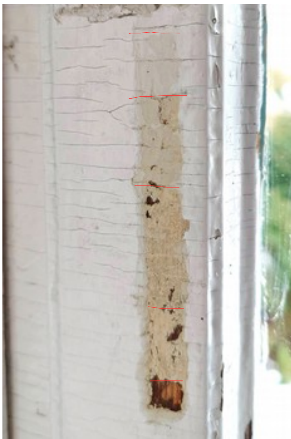
FOT.8 Zbliżenie na wewnętrzną część okna parteru strony zachodniej. Czerwienią określono kolejne warstwy historyczne na stratygrafii znajdującej się od strony wewnętrznej okna. W warstwie pierwotnej widać leżący na drewnie ciemny brąz oryginalnego wymalowania.
