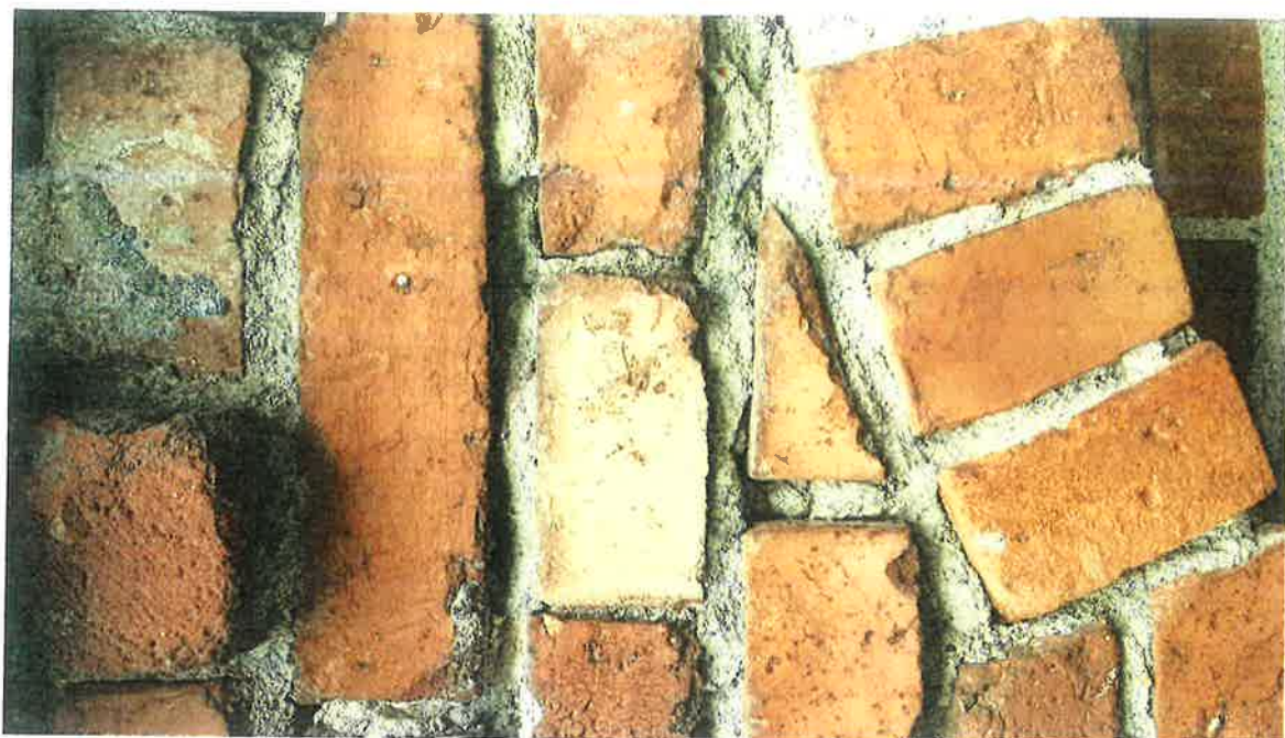
Zabrudzenia powierzchniowe chemiczne oraz zaprawą mineralną.
