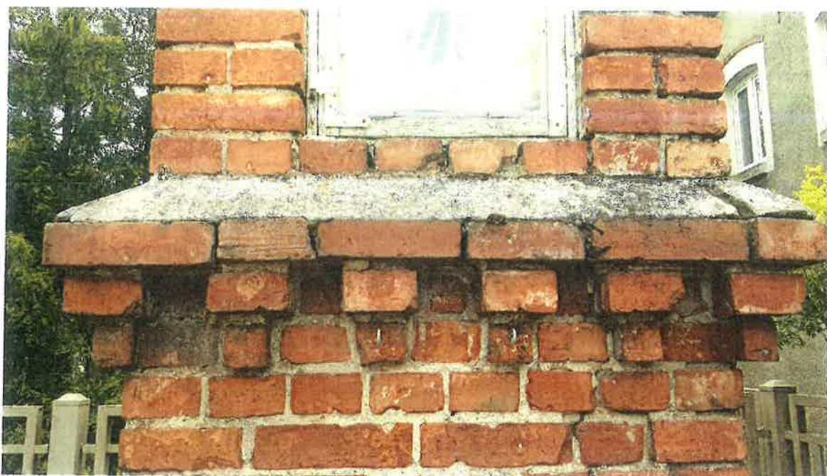
Zdegradowany okap gzymsu oraz braki spoin. Poniżej pęknięcie muru.
