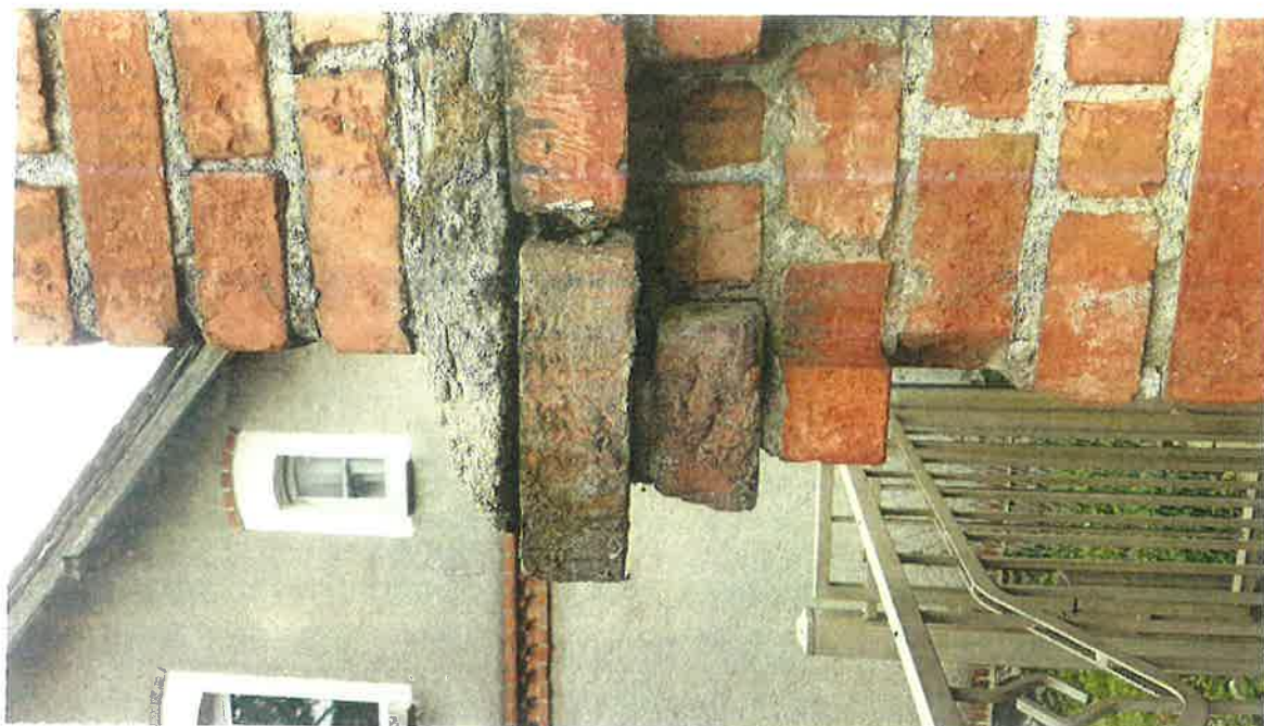
Odspojony okap gzymsu.
