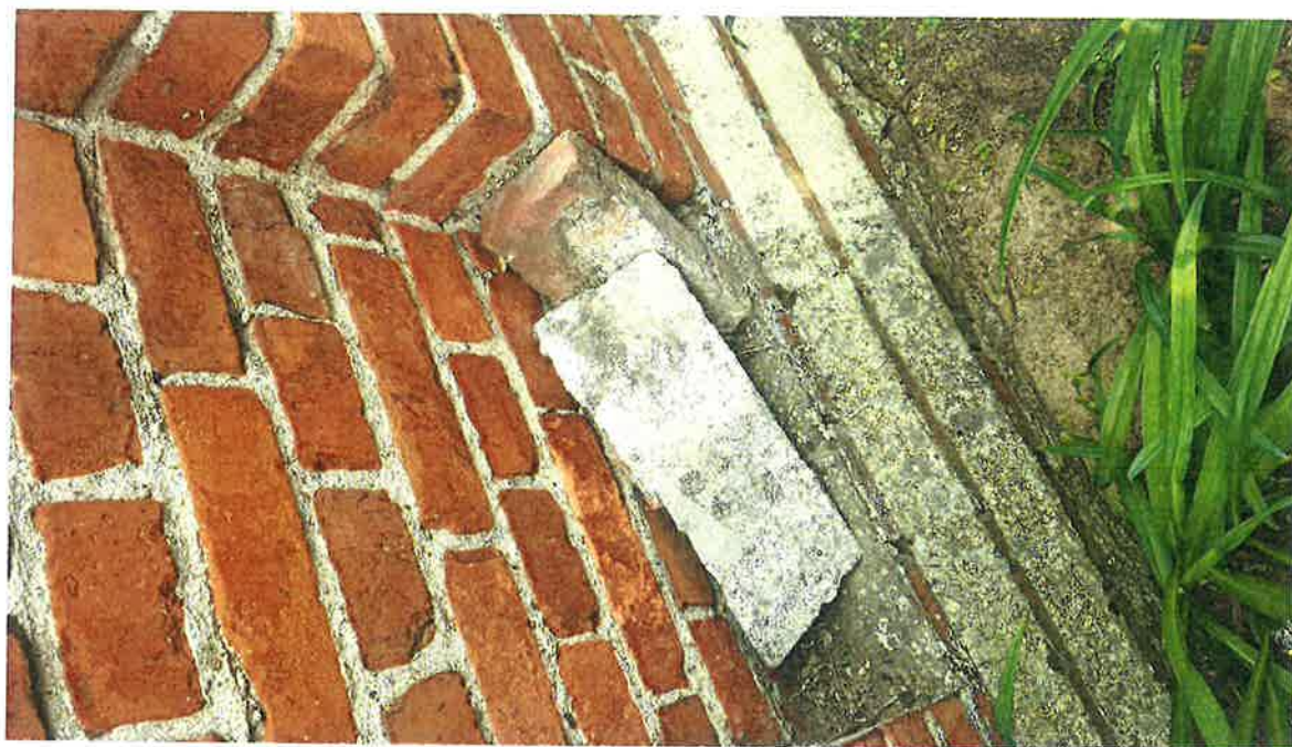
Obluzowana cegła gzyms zabezpieczona w dnie blendy.
