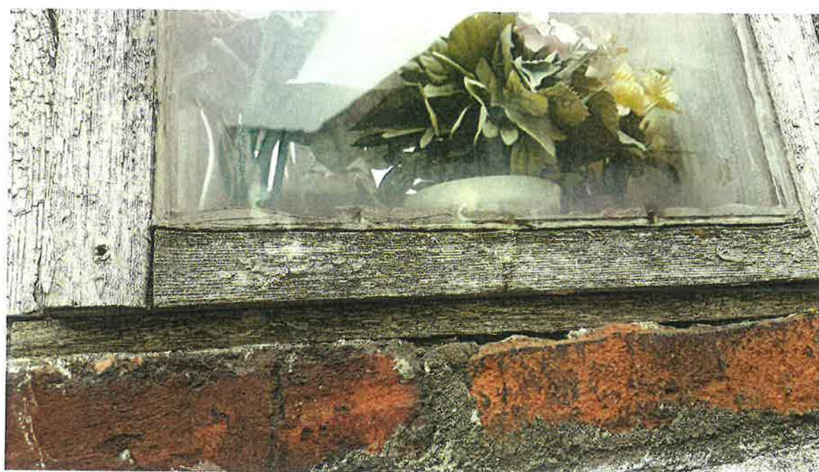
Silnie zdegradowana stolarka okienna.
