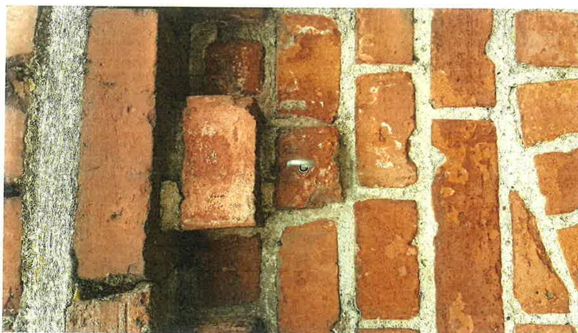
Współczesne elementy mocujące wprowadzone w wążek ceglany.
