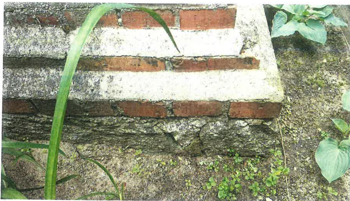
Zdegradowany okap stopni podstawy. Widoczny odsłonięty fragment kamiennego fundamentu.
