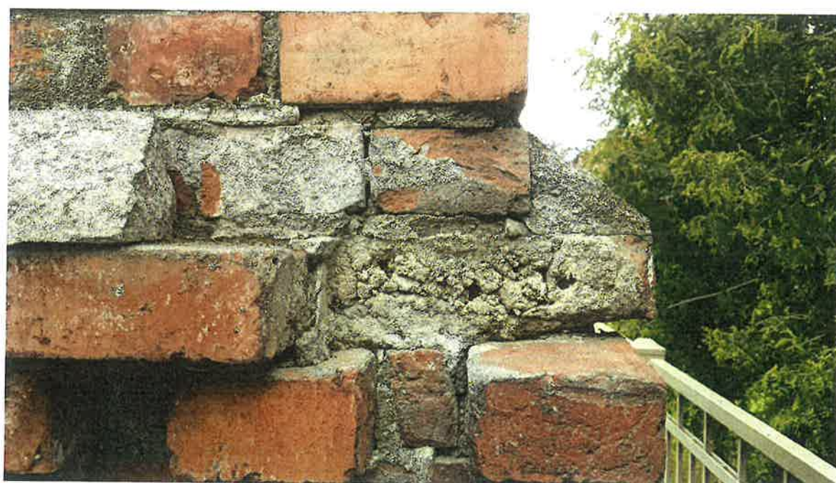
Ubytek cegły w wątku gzymsu.
