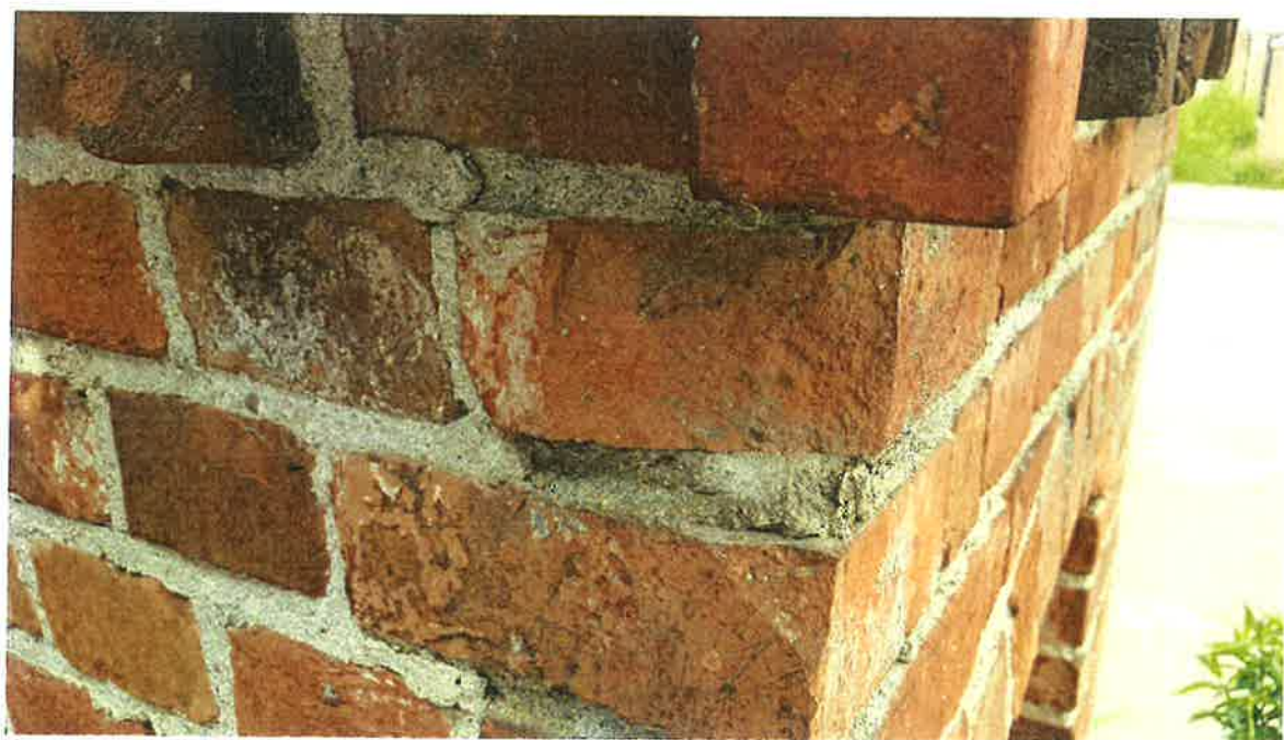
Zniszczenia cegieł powstałe wskutek wietrzenia oraz ubytki mechaniczne.
