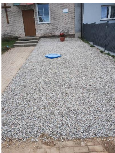
Budowa przyłącza w m. Dybówko
