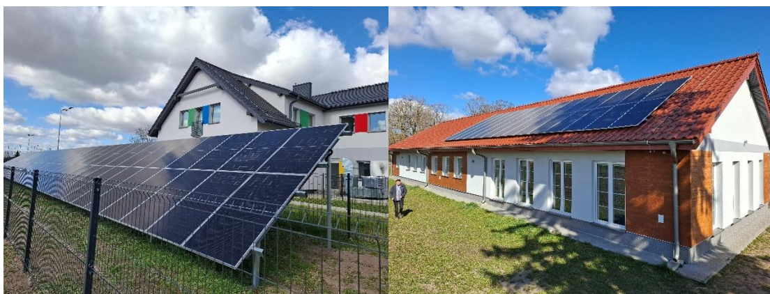
"Zielone Prostki" - montaż odnawialnych źródeł energii na budynkach użyteczności publicznej oraz na terenach infrastruktury technicznej.
