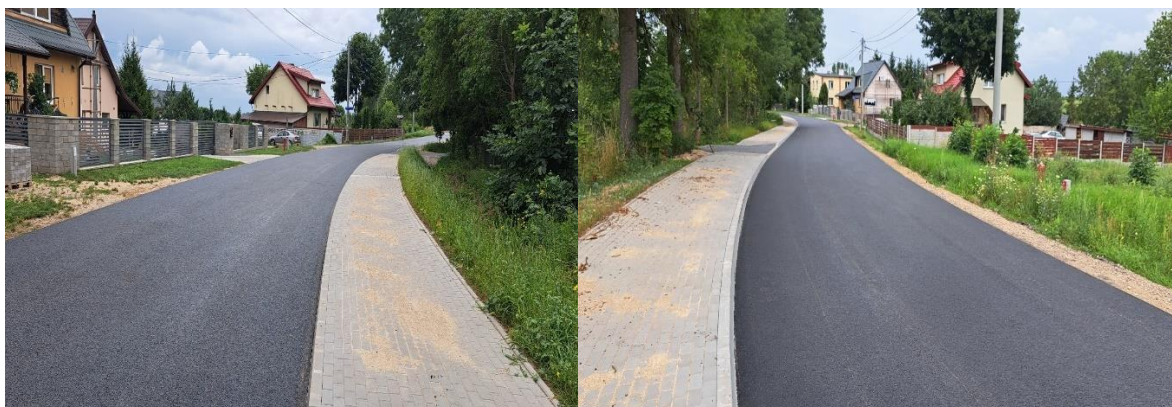
Przebudowa drogi powiatowej w Wiśniowie Ełckim
