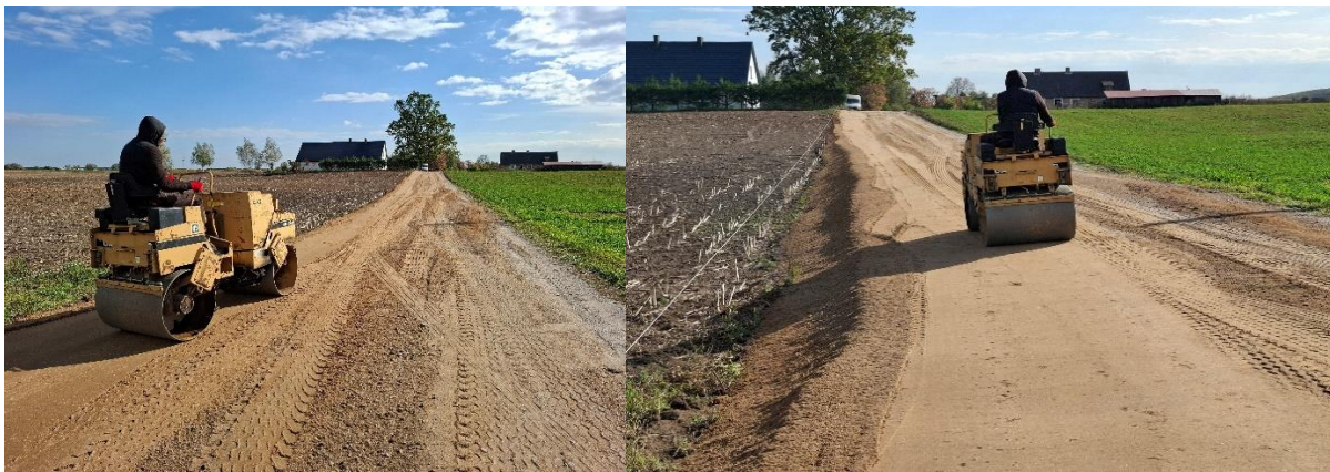
„Remont dróg o nawierzchni żwirowej na terenie gminy Prostki”
