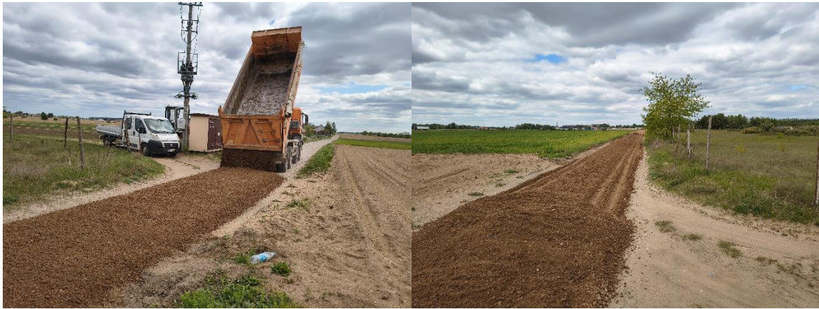
„Remont dróg o nawierzchni żwirowej na terenie gminy Prostki”
