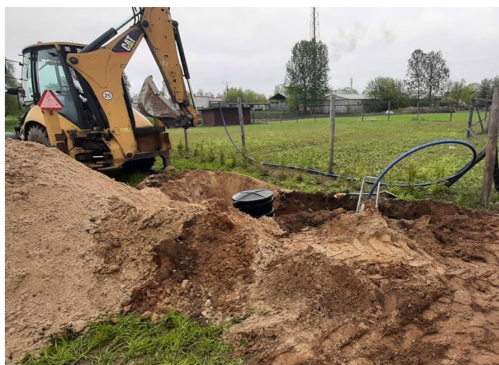
Budowa przyłącza w m. Prostki
