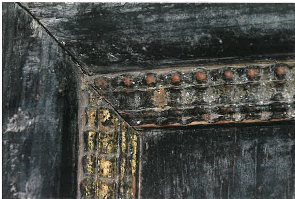
91. Fragment ramy – stan zachowania: widoczne: rozwarstwienie łącza i relikty złocień.
